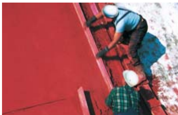
Réglage d'une chape (le mortier est ici coloré grâce à des pigments minéraux).
