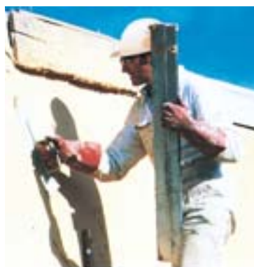
Serrage d'un enduit à la spatule.
