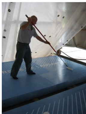
Éléments en béton bleu teintés par lasure et protégées avec anti-graffiti permanent
