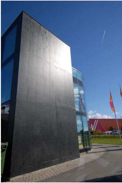
Deux exemples de bétons teintés dans la masse apparents avec des types de protections différentes
