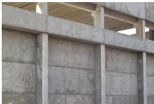
Manque d'huile de démoulage (à gauche arrachage à cause d'un manque d'huile, à droite excès d'huile)
