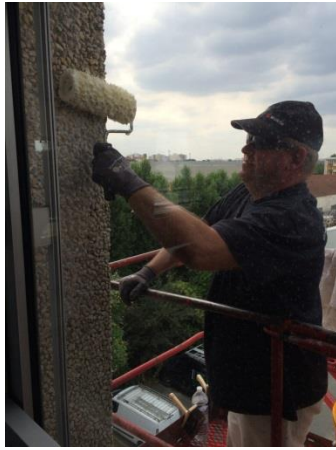
Hydrofuge en crème appliqué au rouleau / hydrofuge crème appliqué avec la pulvérisation airless
