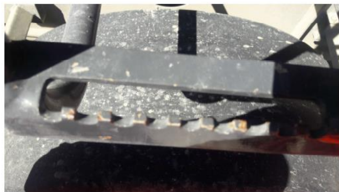
Vue de détail d'un barreau de l'échelle
