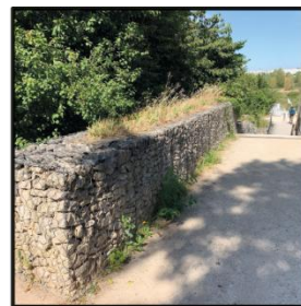
Les murs en gabion
