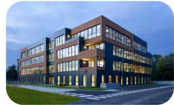
Wooden Park - Basso Combo Bétons à base de GR by Cemex
