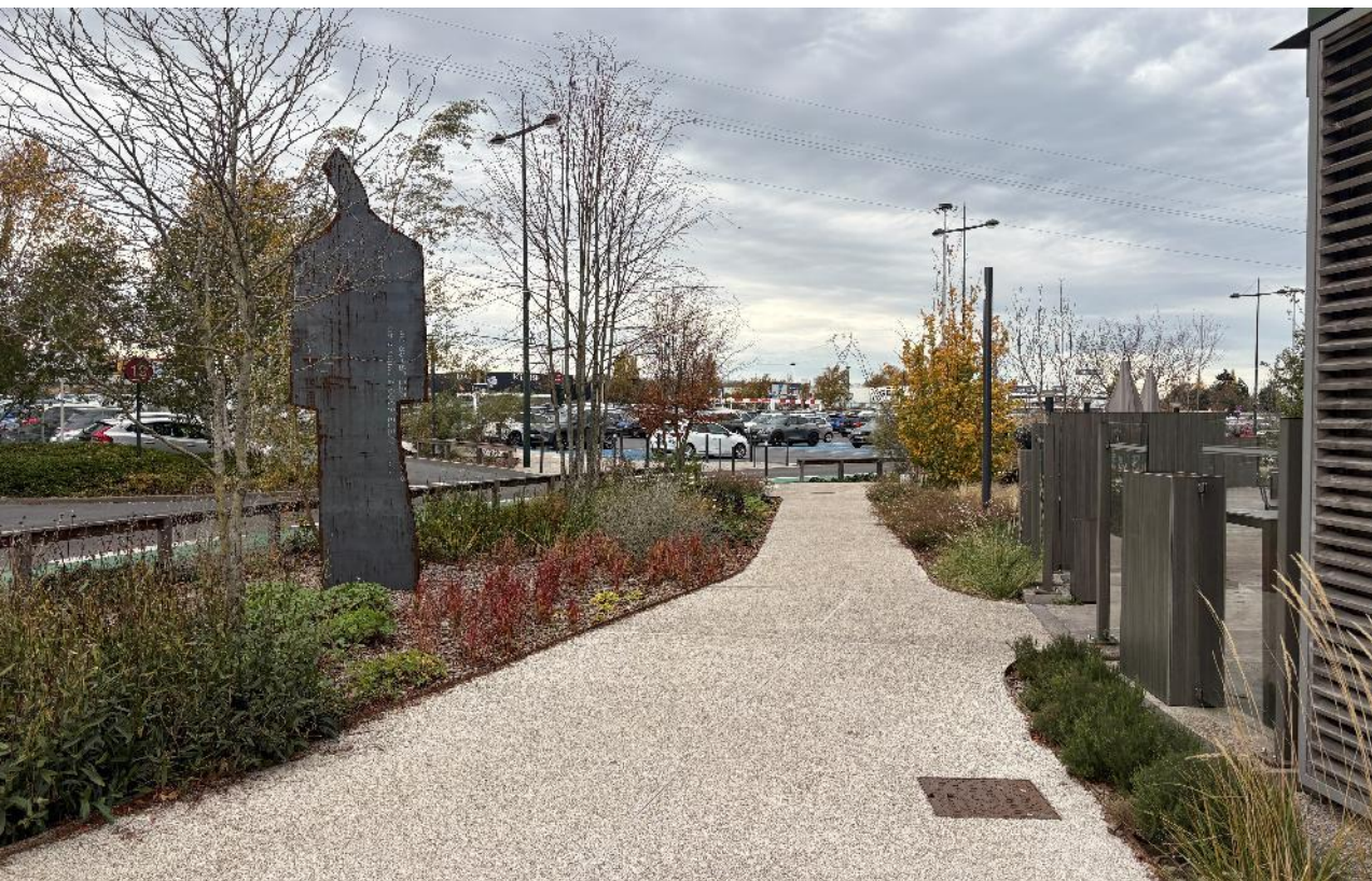
BÉTON DRAINANT (égrésé) Centre Commercial Auchan - Englos
