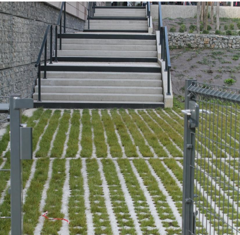
BÉTON VÉGÉTALISÉ Stationnement – Notre Dame de Gravenchon
