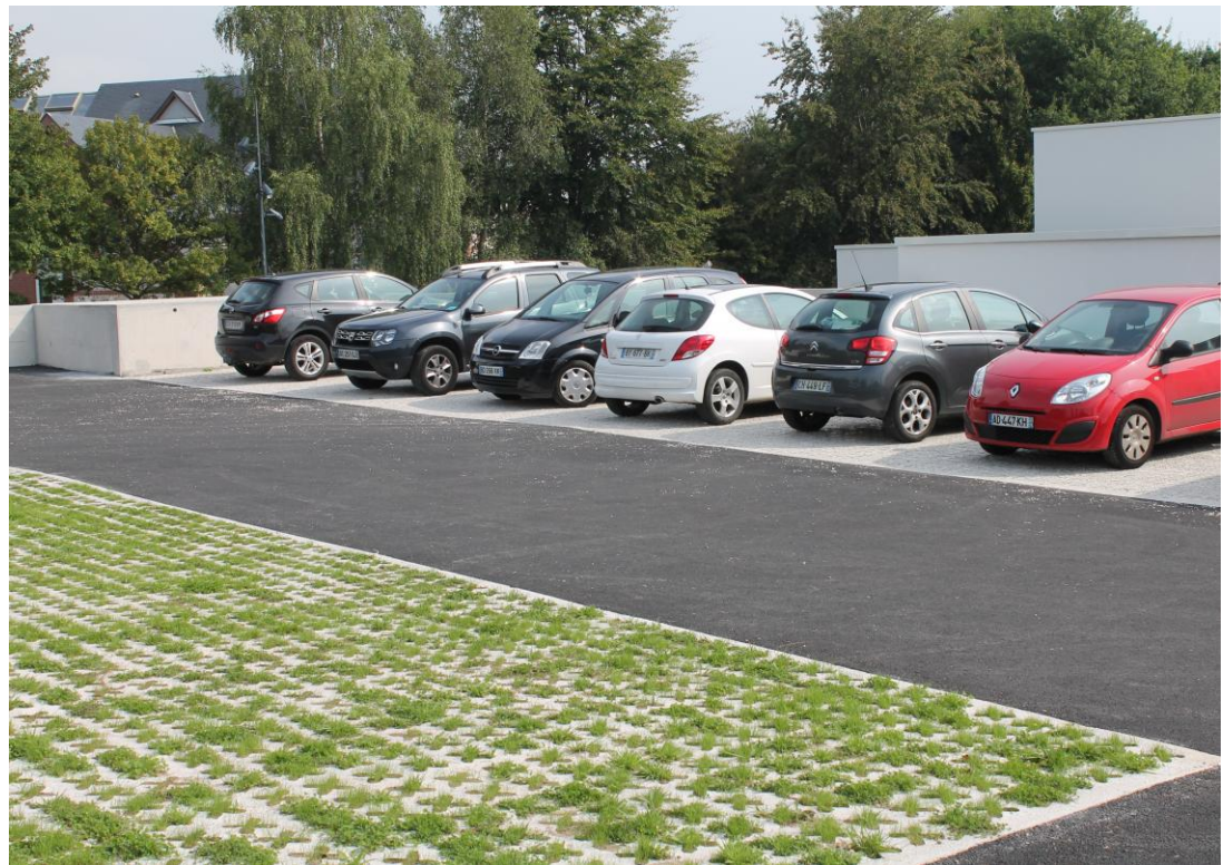
BÉTON VÉGÉTALISÉ Stationnement – Notre Dame de Gravenchon
