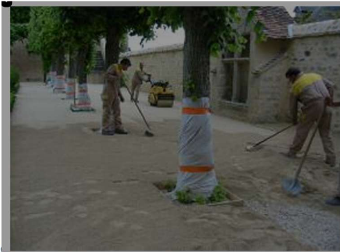
Abords de la Maison du Tourisme à Alençon : mise en œuvre et compactage, sur un support en GNT, d'un sable stabilisé avec un liant hydraulique routier spécifique.
