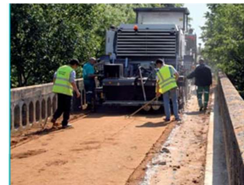
Le malaxeur mélange le liant hydraulique routier avec le sable en place.
