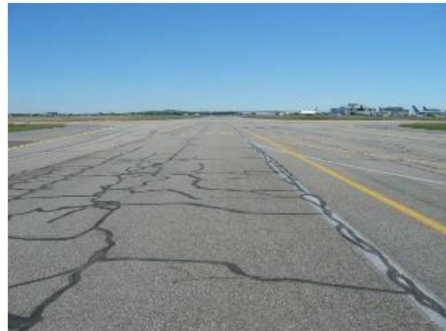
Ces simples dégradations de surface sont alors traitées grâce à une **réfection de la couche de roulement** ou un **retraitement à l'émulsion de bitume**.
