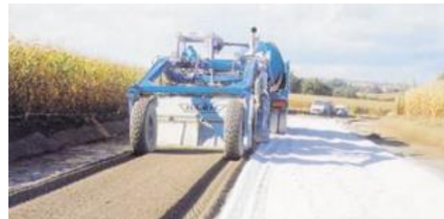
Malaxage en place
