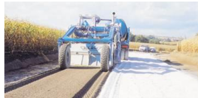
Malaxage en place
