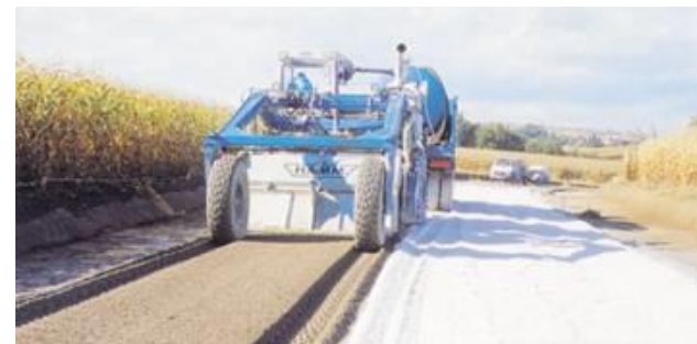
Malaxage en place
