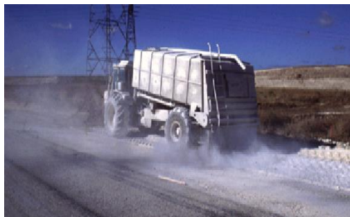
Malaxage et humidification du matériau par injection d'eau sous la cloche
