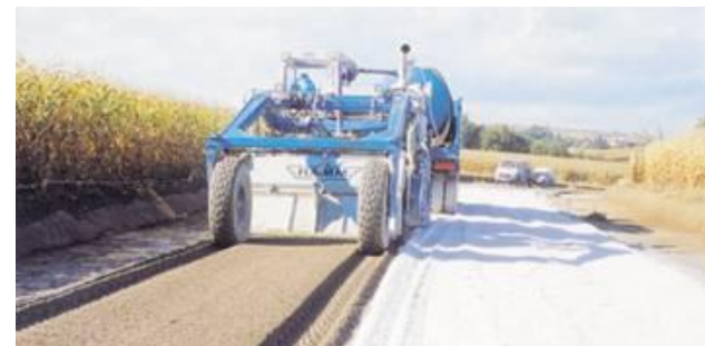
Malaxage en place
