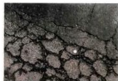
Chaussée avant retraitement
