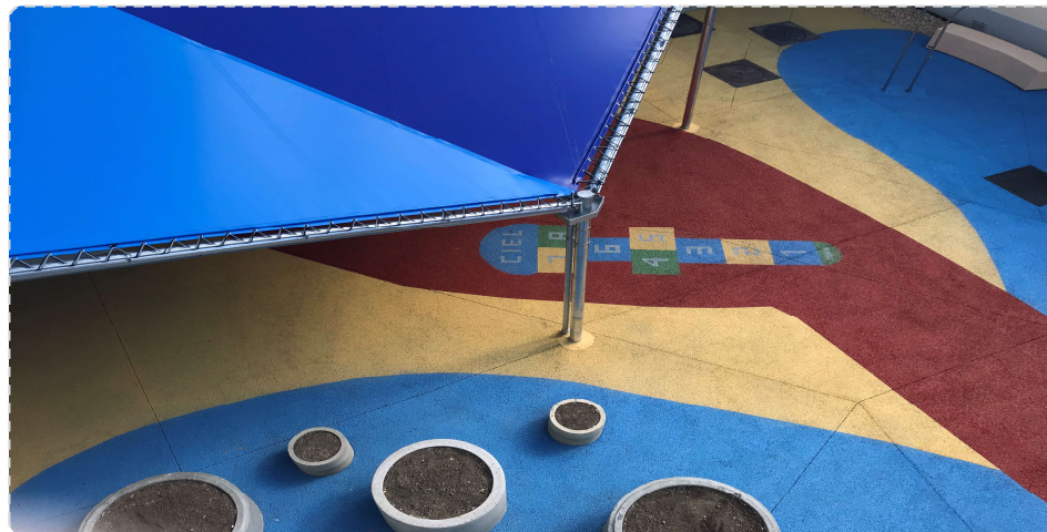
Béton drainant — Ecole cours OASIS
