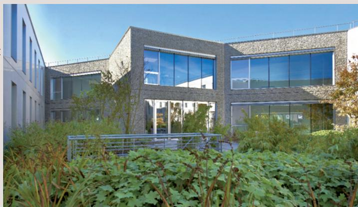
**Conçu** par l'agence Hobo Architecture, dans une démarche de certification HQE® (niveau très performant) et de labellisation BBC-Effinergie® l'immeuble Odyssee, nouveau siège de la MAAF à Niort, a bénéficié d'un mode constructif unique en son genre. L'ensemble du bâtiment est préfabriqué, avec des éléments de plancher portant jusqu'à 18 m entre façades et des panneaux de façade isolants – double mur isolé – hauteur d'étage.
