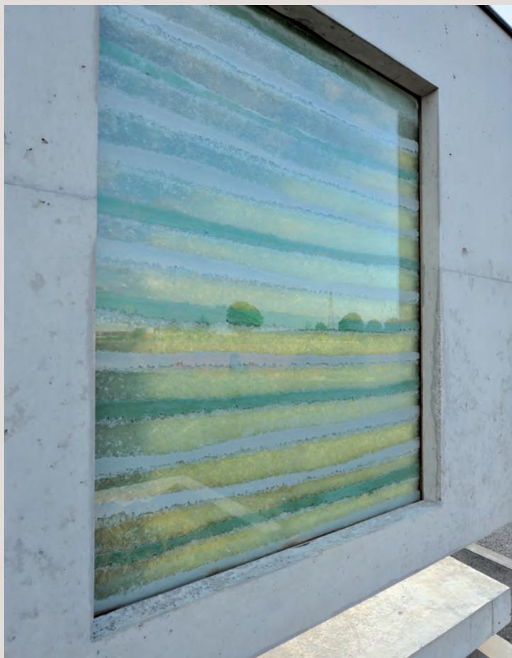
→ « Le béton transparent, c'est un oxymore ». Panneaux autoportants BFUP et résine translucide.
