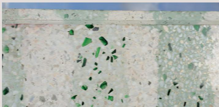
→ Paroi lumineuse de béton poli avec incrustation de morceaux de verre pour l'unité de production d'eau industrielle à Valenton.
