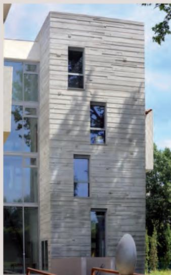
← Un béton « à la plancha », réalisé avec les planches récupérées sur le chantier pour une mise en œuvre complexe et un rendu unique.
