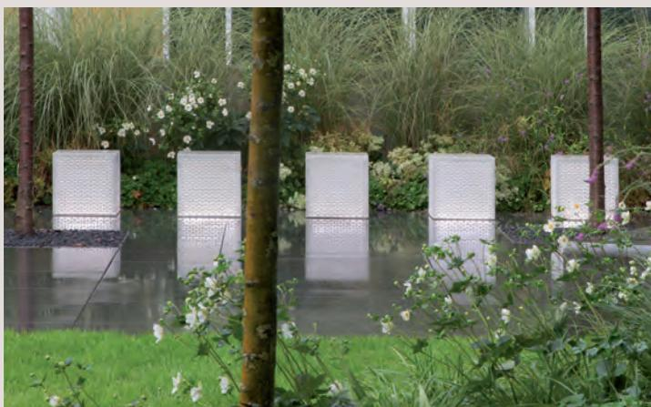
→ Les panneaux de béton « transparent » sont personnalisables à l'infini en modulant les dimensions, la couleur de la matrice cimentaire et/ou celle des résines.
