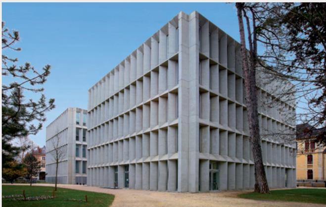
La Cité des arts et de la musique à Chambéry (73) a ouvert ses portes en 2003. C'est l'un des premiers bâtiments à avoir été construit avec un béton autonettoyant. Un béton de couleur calcaire pour cette construction particulièrement exposée aux risques de dépôts et de prolifération de salissures d'origine
