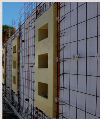
→ Ce procédé de mur banché isolant mis en œuvre sur un chantier de construction de petit collectif assure tout à la fois : isolation homogène et continue, parement de façade matricé et liberté de conception.
