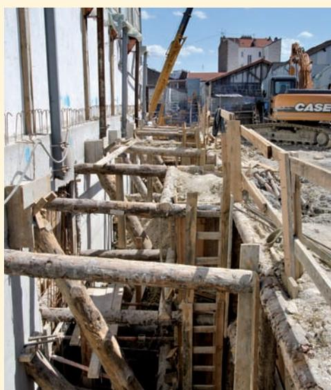
>>> Figure 4. Exemple d'une reprise en sous-œuvre à Montreuil (93). Réalisation des voiles mitoyens par phases successives. Blindage du voile par butons en bois.
