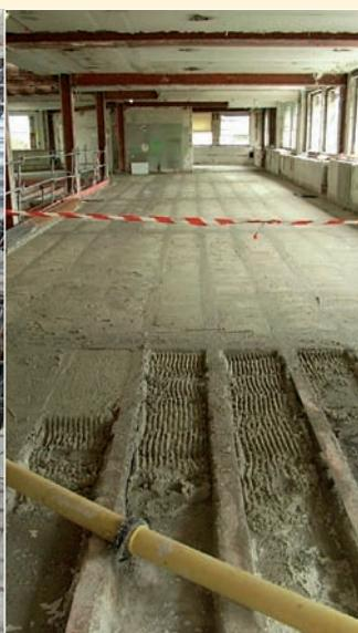
>>> Figure 21. Béton léger de remplissage des espaces entre les solives métalliques permettant la pose d'une chape flottante.
