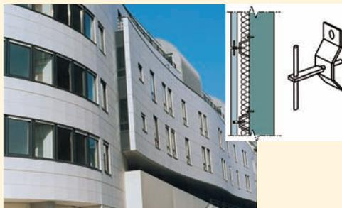
>>> Figure 10. Vêtire en béton fixée mécaniquement et protégeant une isolation par l'extérieur (logements à Paris, Thurnauer et Aygalinc architectes).
