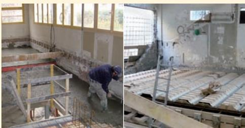
➤➤➤ Figure 15. Maison TP. Disposition des poutrelles précontraintes et des hourdis reconstitués sur des lisses d'étalement. Coulage du béton à la pompe disposée dans la rue à 100 m.
