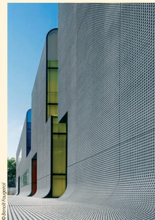
>>> Figure 11. Centre de bus à Thiais (94) (ECDM Architectes) : panneaux de façade en BFUP.
