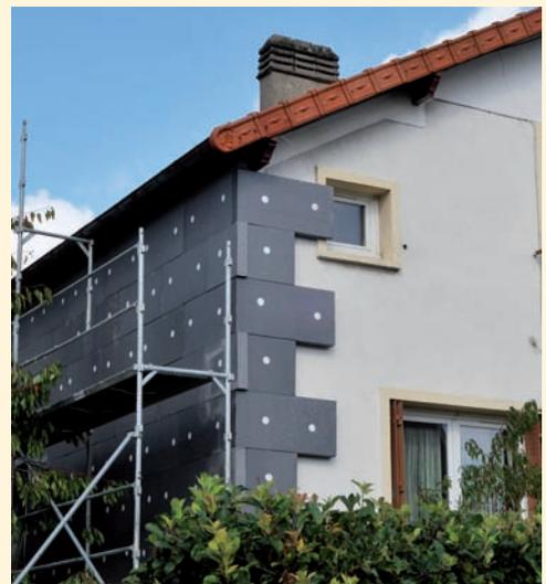
>>> Figure 9. Isolation thermique par l'extérieur appliquée en réhabilitation d'une maison individuelle. Isolant en cours de pose.
