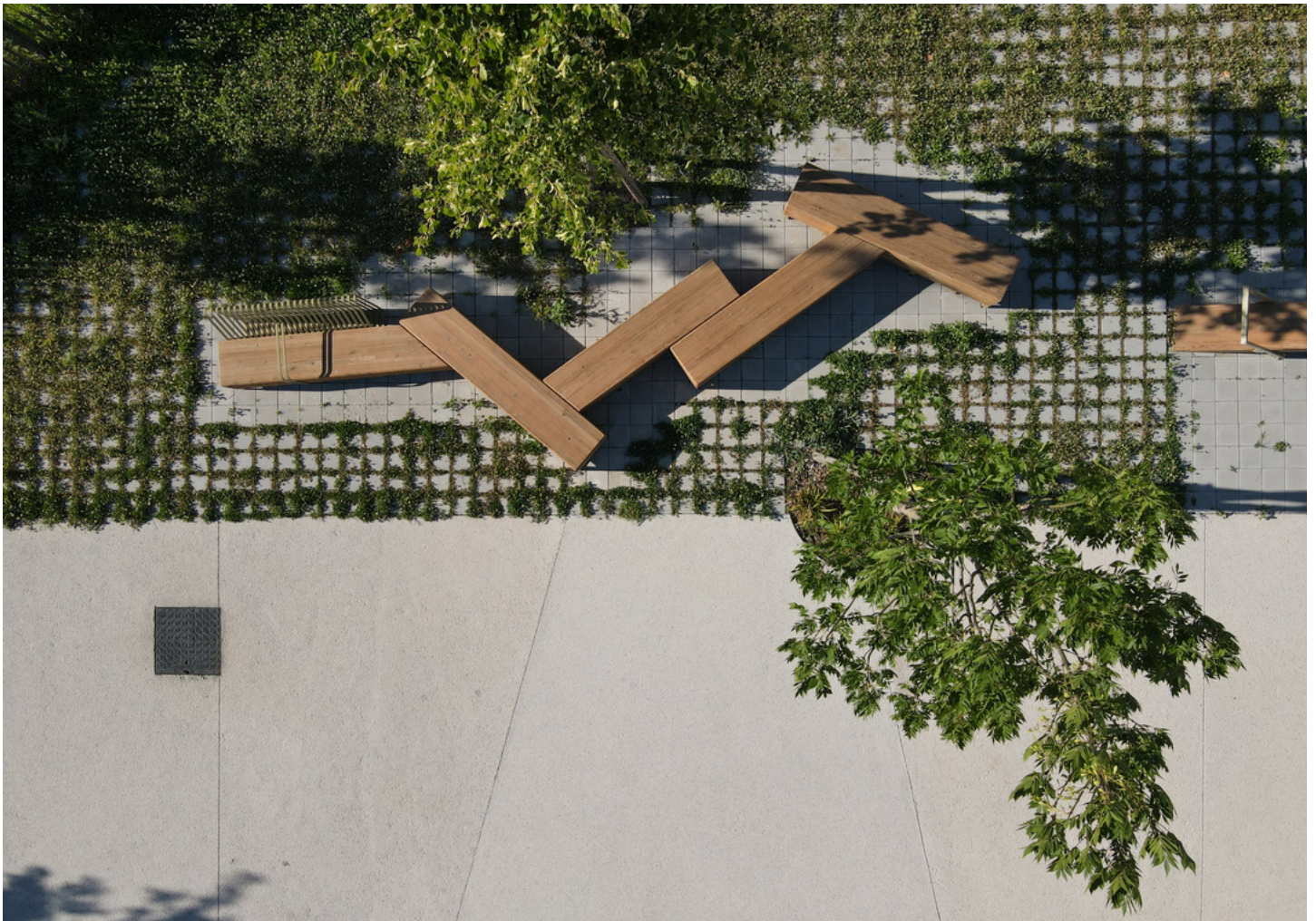
↑ Petit Champ. 9000 m 2 de cheminements principaux sont réalisés en béton recyclé et à empreinte carbone réduite. (© Agence Base)
