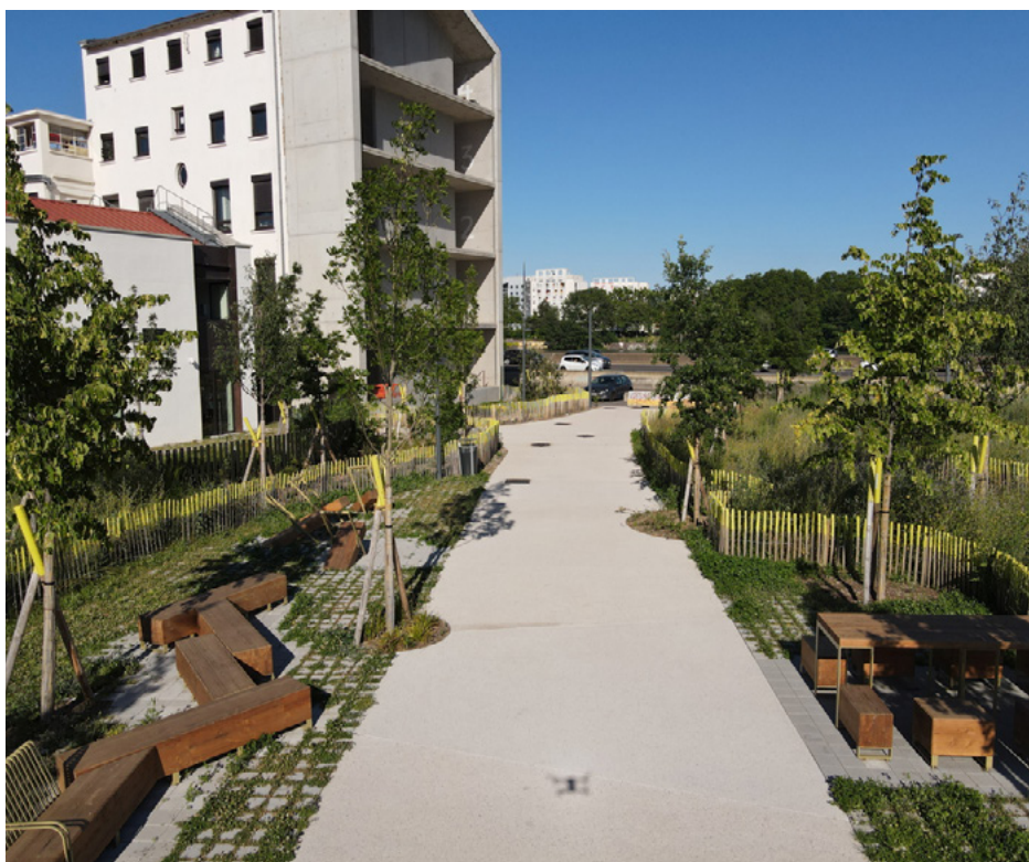
↑ Petit Champ. Les premiers bétons 100 % recyclés et à empreinte carbone réduite (sur base de pouzzolane) ont été réalisés en 2019 (en finition sablée). (© Agence Base)
