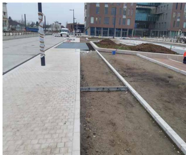
↑ Un joint de dilatation goujonné est réalisé tous les 25 m.
