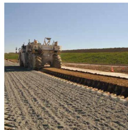
▲ Malaxage du matériau avec le LHR par un malaxeur Wirtgen.
