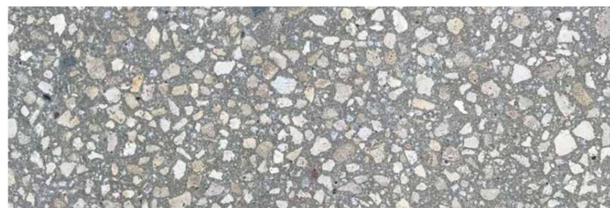
← Deux bétons formulés avec des granulats locaux de teintes différentes permettent de différencier les usages.
