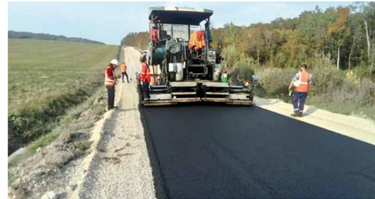
▲ Mise en œuvre de la couche de surface en BBCS à l'aide d'un finisseur.
