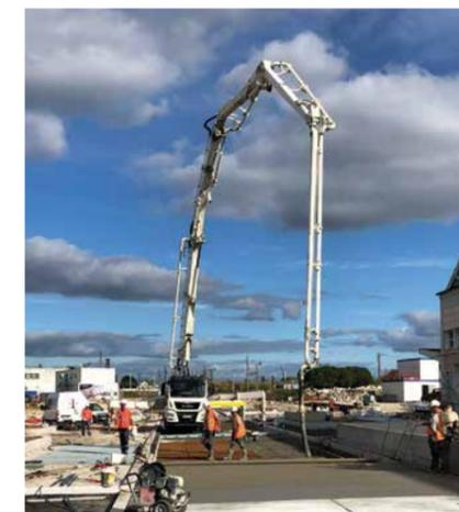
Bétonnage à la pompe et serrage du béton à l'aide d'un rouleau Striker.
