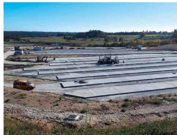
↗ Application de la technique du clavage. Coulage d'une bande sur deux.
