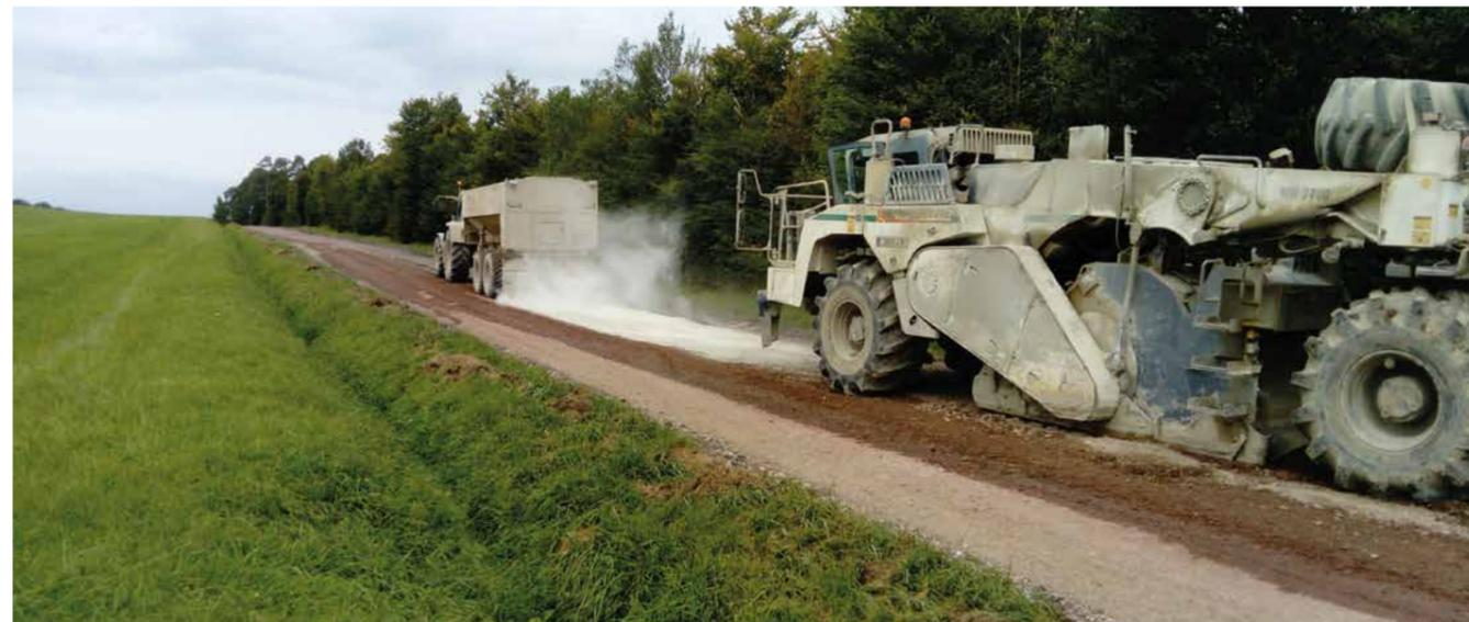
Chaussée rabotée et élargie à 6,60 m. Atelier de prétraitement en place à la chaux en action.
