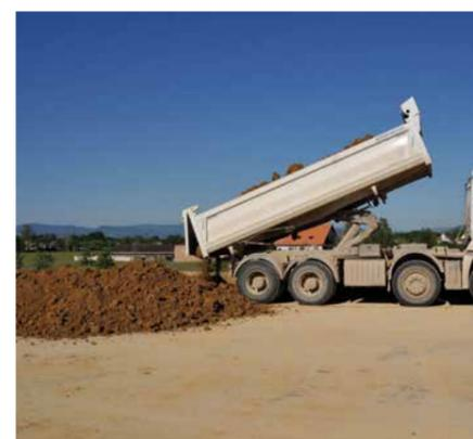
▲ Acheminement des matériaux depuis le dépôt provisoire et mise en place sur site pour une épaisseur finale de 35 cm.
