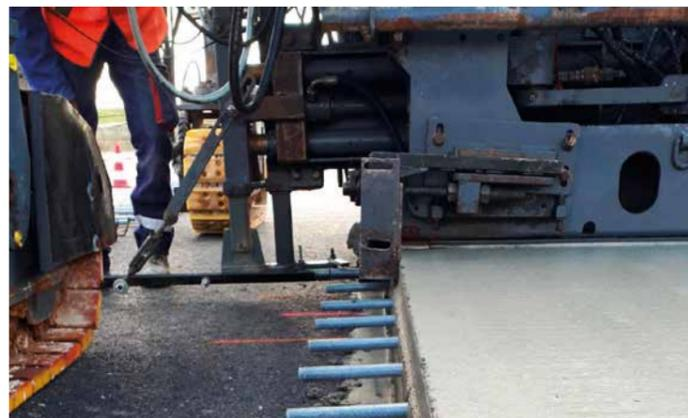
↑ Insertion des goujons à mi-hauteur sur les deux flancs de la bande en béton. (© Luc Lefoll\_Eurovia)
