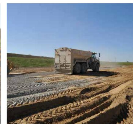
▲ Après scarification, épanchage du liant hydraulique routier.
