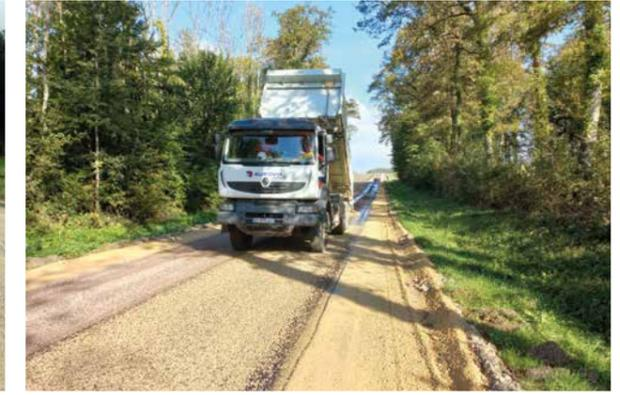
▲ Mise en œuvre de l'enduit superficiel de protection.
