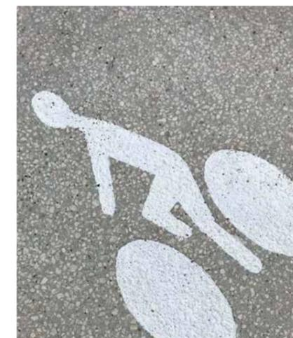
↑ Un des intérêts du béton est de permettre d'imprimer par la méthode du pochoir des dessins durables en surface.
