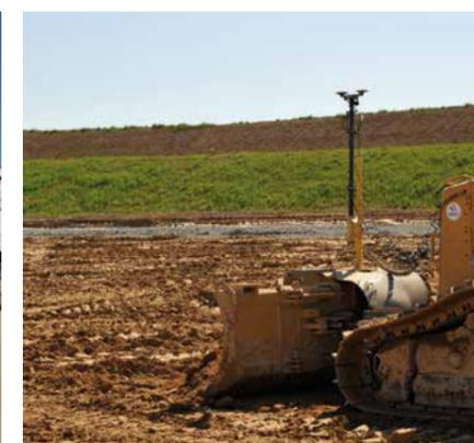
▲ Préréglage à l'aide d'un bull asservie GPS afin d'obtenir une épaisseur homogène avant traitement.
