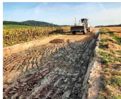
Travaux de remblayage des purges effectués en pleine largeur.
