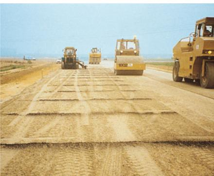
▲ Atelier de compactage du BCR, constitué de rouleaux vibrants suivis d’un compacteur à pneus. (©Cimbéton)
