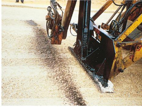
⤴ Réalisation de la préfissuration à l'aide de la machine Craft Émulsion®. (©Cimbéton)
