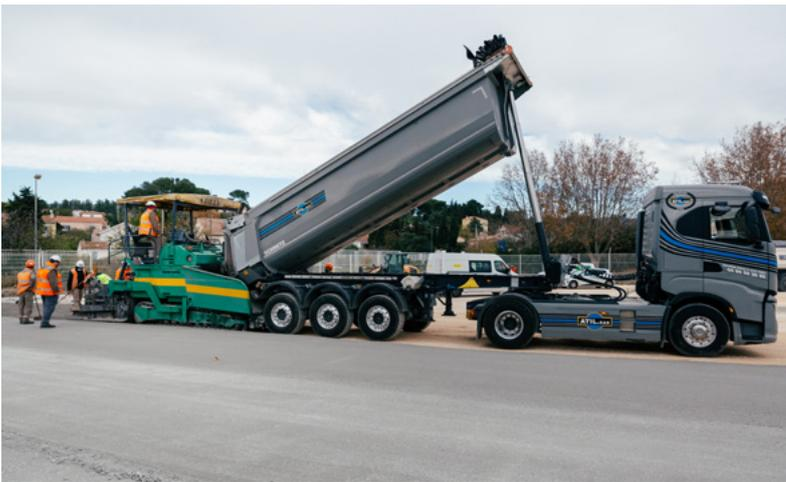
▲ Un camion-benne, bâché durant le transport du BCR, déverse le matériau dans le finisseur. Celui-ci répand, nivelle et compacte le BCR. (©Colas)
