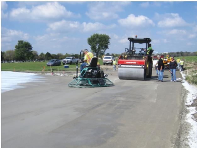
⤴ L'adjuvant spécial au BCR s'applique sur la surface juste avant le passage de la truelle mécanique, avec un pulvérisateur à grand débit. Il permet au béton d'être taloché fin, avec suffisamment de pâte cimentaire en surface. (©Moderne Méthode/Chryso)
