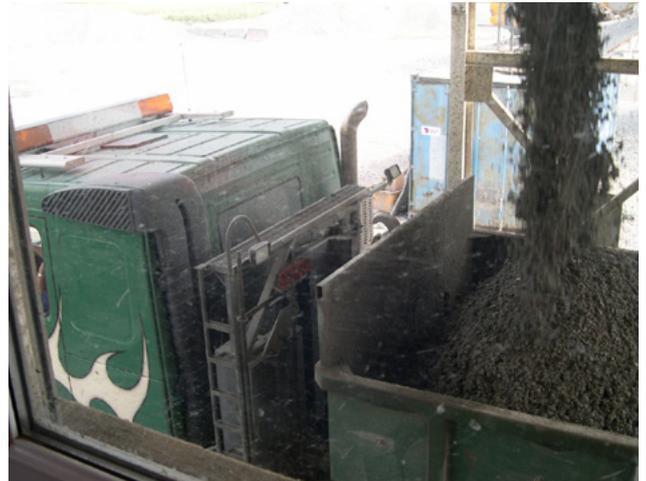
▲ Le BCR peut être fabriqué dans une centrale continue de type grave traitée. (©Cimbéton)
