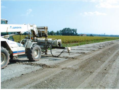
⤴ Réalisation de la préfissuration à l'aide de la machine Olivia®. (©Cimbéton)
