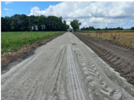
▲ Epandage du liant ROC VDS à la surface des fraisats d'enrobé à l'aide de l'épandeur Streumaster SW18CI (LTV 333). (©Colas)
