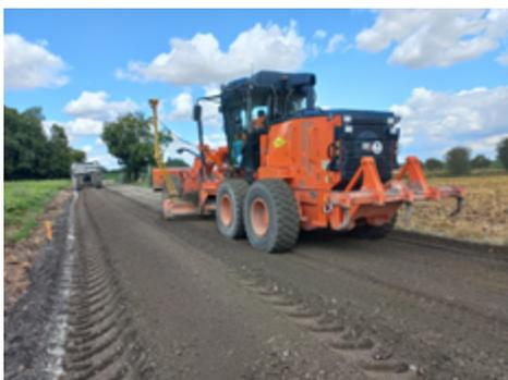
▲ Le retraitement au LHR est suivi par un nivellement et la mise au profil du matériau. (©Colas)
