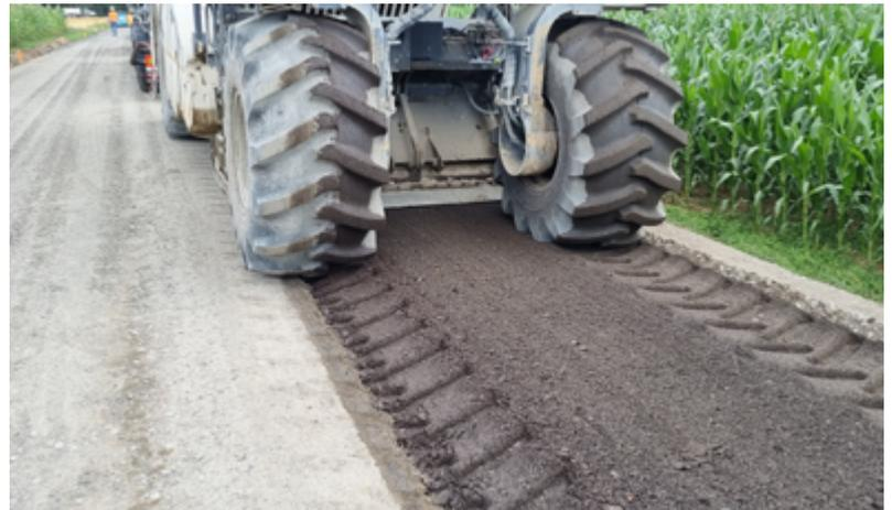
⤴ Section 3. Atelier de retraitement mixte au liant ROC VDS (liant épandu au sol) et à l'émulsion de bitume (injectée directement dans la cloche du malaxeur. (©Colas)
