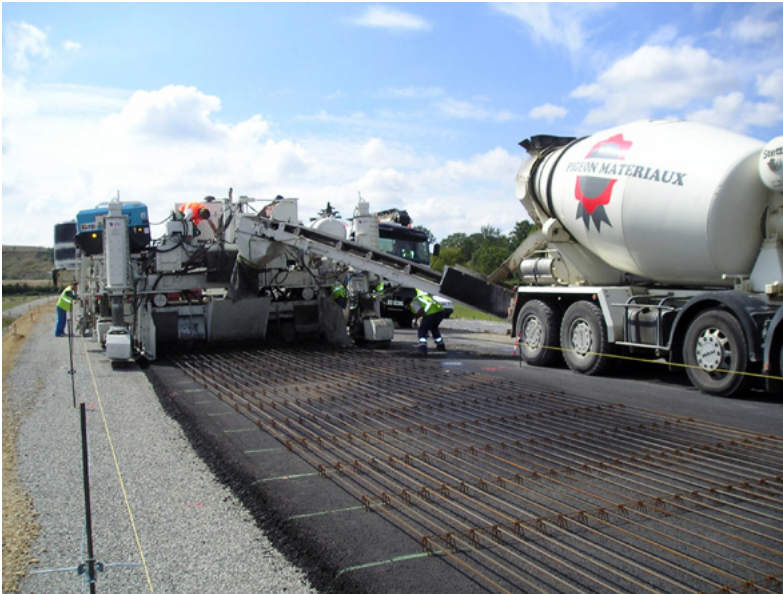
↗ Chaussée composite BC5g/GB3
