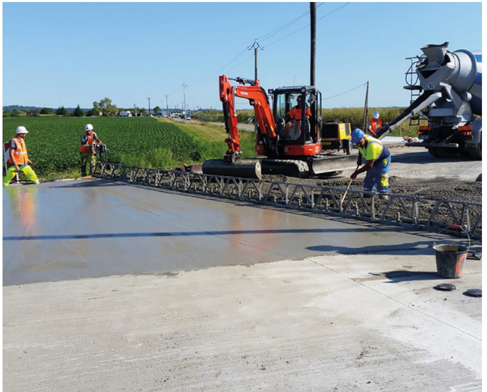
➤ Le giratoire de Pérourges, sur la RD65b, lors du bétonnage. La société Agilis a utilisé une règle vibrante pour assurer la mise en place du béton.
