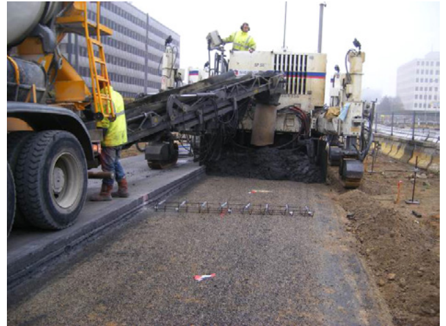
↗ Chaussée composite BC5g/GB3
