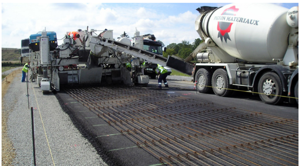
⬆ BAC. Positionnement des armatures longitudinales sur des supports ou « distanciers ».
