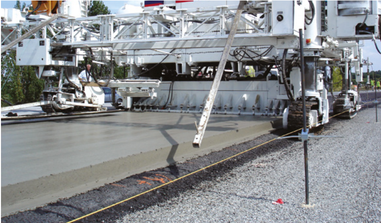
⬆ Mise en œuvre d'une structure en BAC/GB3. La propreté de la grave bitume est indispensable pour assurer le collage à l'interface béton/grave bitume
