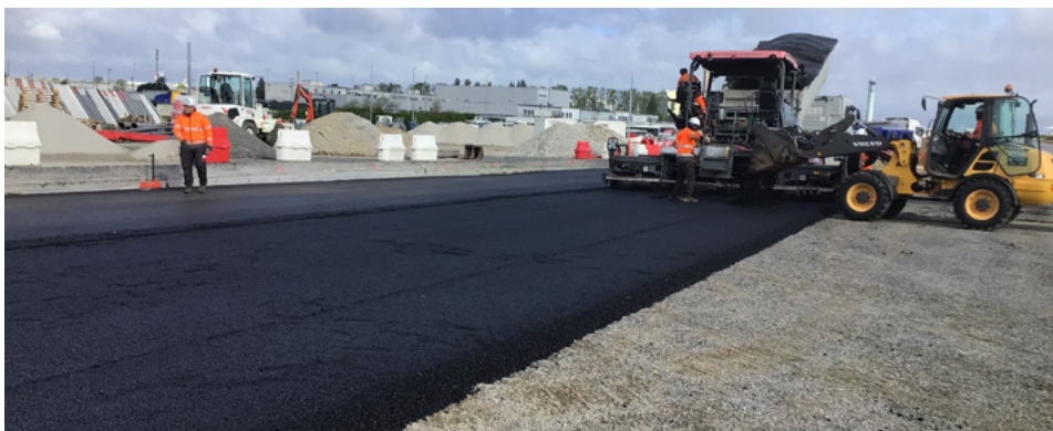
➤ Paris CDG, chaussée composite en BC6g/GB5 pour une aire de circulation avion. Mise en œuvre de la GB5.
