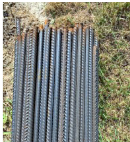
▲ Armatures longitudinales du BAC
