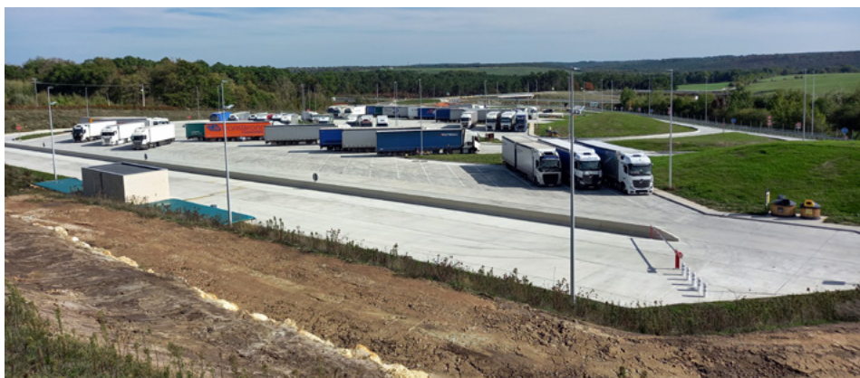
➤ RN 10. Aire de la Grolle. Chaussée composite en BC5g sur GB3. (photo © Gilles PETIT / DIRA)
