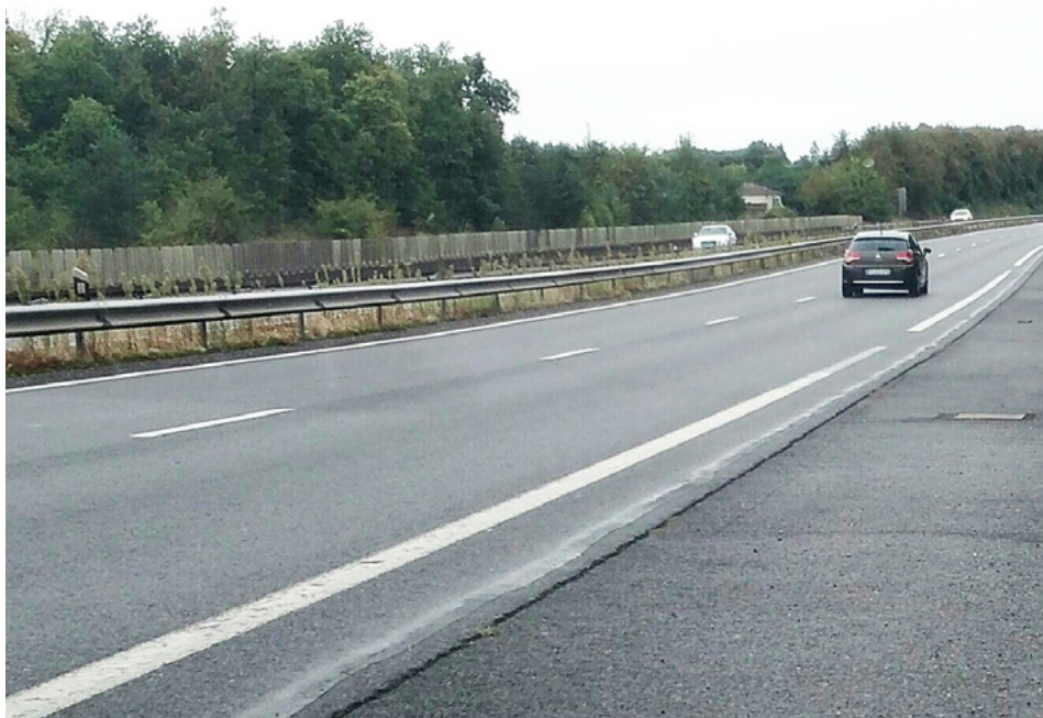
➤ RN 141. Déviation des Rassats-Favrauds en BBTM/BAC/GB3.
