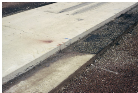
⬆ Les résultats de FABAC : Tenue de la structure après plusieurs millions de passages d'Essieux Standards.
