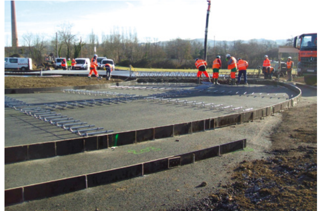
⬆ Mise en œuvre d'une structure en BC5g /GB3. La propreté de la grave bitume est indispensable pour assurer le collage à l'interface béton/grave bitume.
