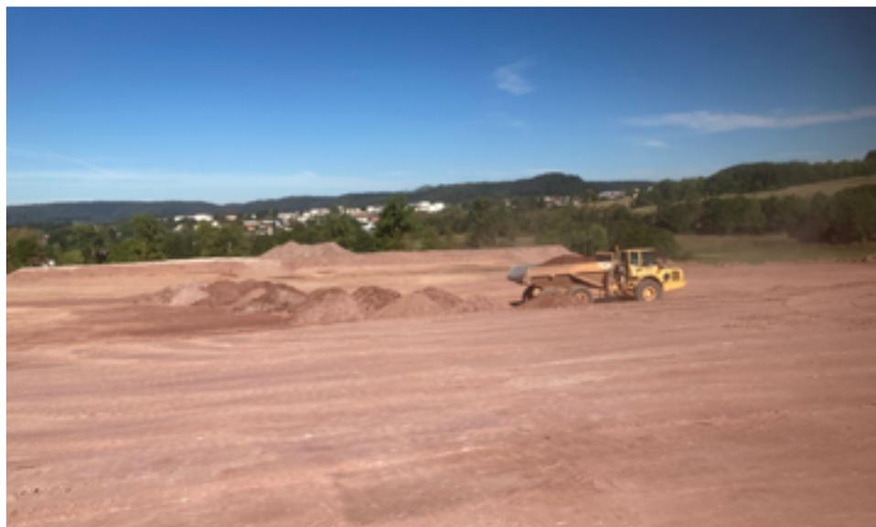
➤ Mouvement de terre. Le matériau est acheminé et mis en place en couches d'épaisseur variable en fonction de la zone, afin de conférer à la plate-forme les caractéristiques topographiques visées. (© Scierie-Gaiffe et Avinim Construction)
