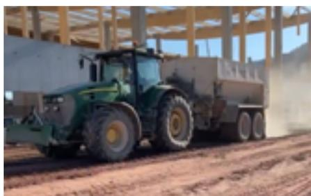
⤴ Épandage du liant avec précision à l'aide d'un épandeur tracté Streumaster.
