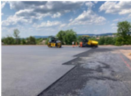
⬆ Mise en œuvre de la couche de surface en BBSG. (© Scierie-Gaiffe et Avinim Construction)
