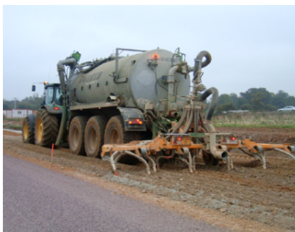
⬆ La teneur en eau du sol est ajustée à la teneur de l'optimum Proctor à l'aide d'une arroseuse-enfouisseuse. (©Colas)
