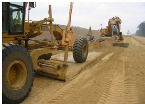
⬆ Mise à la côte du matériau avant le passage de l'atelier de traitement. (©Colas)
