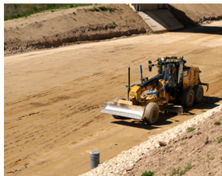
⬆ Réglage à la niveleuse pour obtenir un profil en long très régulier. (©Colas)
