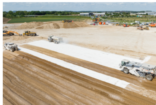
⬆ Atelier de traitement. Au fond un épandeur du liant en action et au premier plan deux pulvimixeurs mélangent le liant avec le sol sur une épaisseur bien définie. (©Colas)
