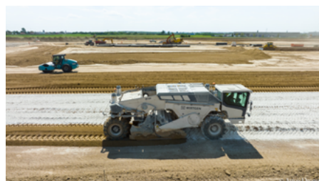
⬆ Le sol est malaxé avec le liant à l'aide d'un pulvimixeur moderne. Au fond, un compacteur en action. (©Colas)
