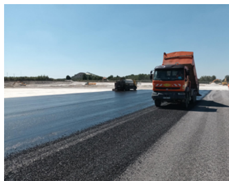
⬆ Atelier de mise en œuvre de l'enduit bicouche clouté dont le rôle est d'assurer la protection du sol traité. (©Colas)
