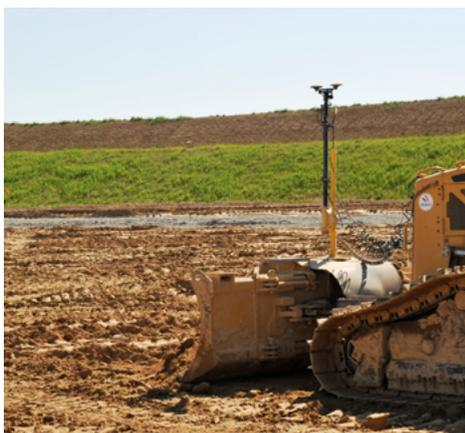
⤴ Préréglage à l'aide d'un bull asservi GPS afin d'obtenir une épaisseur homogène avant traitement.
