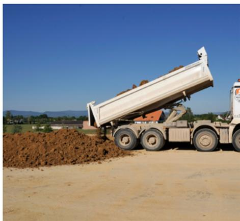
⤴ Acheminement des matériaux depuis le dépôt provisoire et mise en place sur site pour une épaisseur finale de 35 cm.
