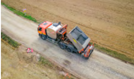
↗ Mise en œuvre de l'enduit de protection.
