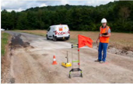
↗ Contrôle de compactage au gamma-densimètre.
