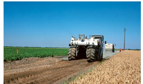
À gauche, l'épandeur à liant de RCM. À droite, le malaxeur Wirtgen 2400 intervenant sur une épaisseur de 45 cm de profondeur.
