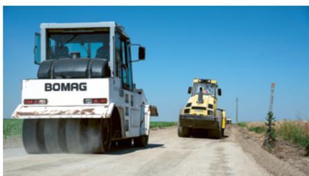
L'atelier de compactage composé d'un compacteur à pneumatiques Bomag BW 24 RH et d'un rouleau V5.
