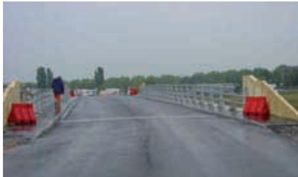
Vue de la chaussée sur l'ouvrage lors de l'inspection détaillée initiale (travaux de finition en cours)
