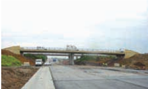
Vue générale de l'ouvrage lors de l'inspection détaillée initiale (travaux de finition en cours)
