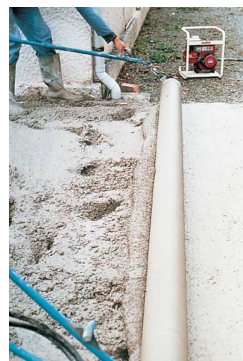
Bétonnage au striker.
