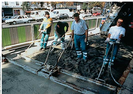
Bétonnage à la règle vibrante.
