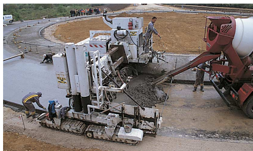
Bétonnage à la machine à coffrage glissant.
