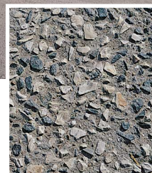
Le béton désactivé, ainsi qu'un choix adéquat des gravillons (couleur, dureté, etc.), sont la solution idéale pour les carrefours giratoires urbains.
