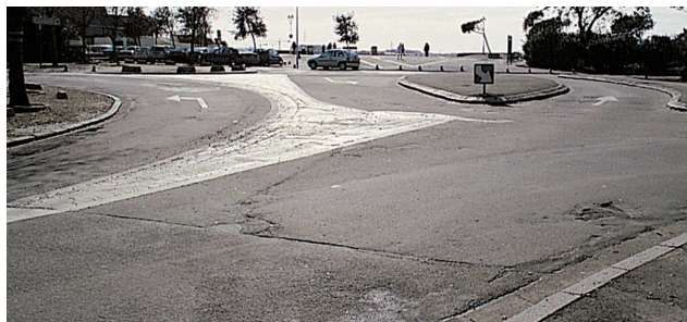
Dégradations structurelles observées sur les carrefours giratoires : faiencage et orniérage des couches bitumineuses.
