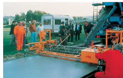
Bétonnage au vibro-finisser.
