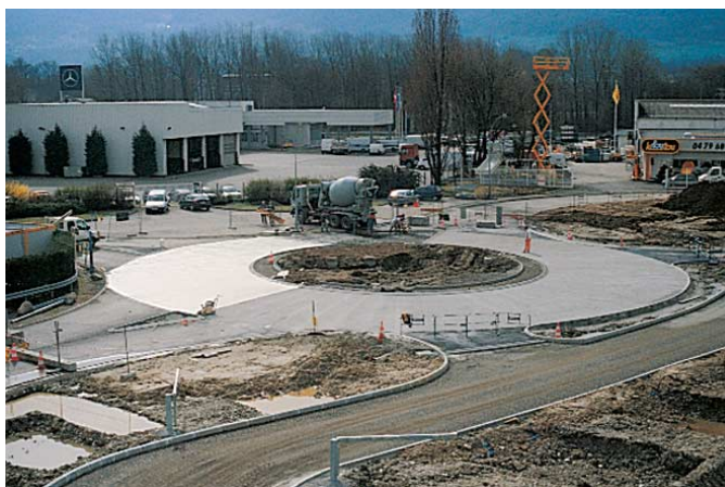
Giratoire des Landiers nord Chambéry (Savoie) : structure neuve en BCMC sur fondation en grave bitume.
