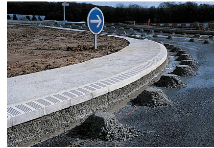
Bordures de l’ilot central posées avant le bétonnage de l’anneau.
