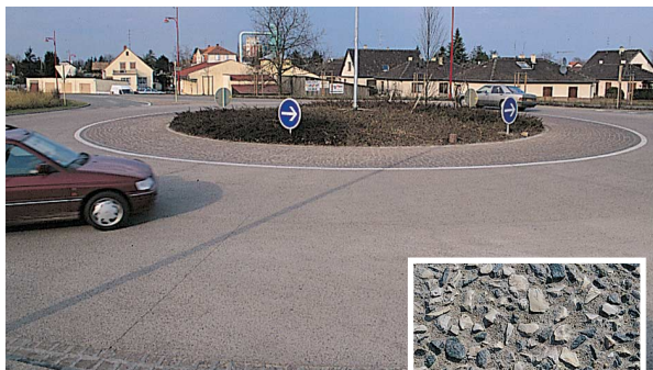
Le béton désactivé, ainsi qu'un choix adéquat des gravillons (couleur, dureté, etc.), sont la solution idéale pour les carrefours giratoires urbains.
