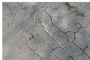
Dégradations structurelles observées sur les carrefours giratoires : faiencage et orniérage des couches bitumineuses.
