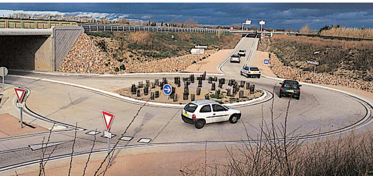
Le carrefour giratoire est un aménagement à réaliser aux intersections de voies. Il est destiné à assurer à la fois la gestion des conflits, la fluidité du trafic et la sécurité des usagers.
