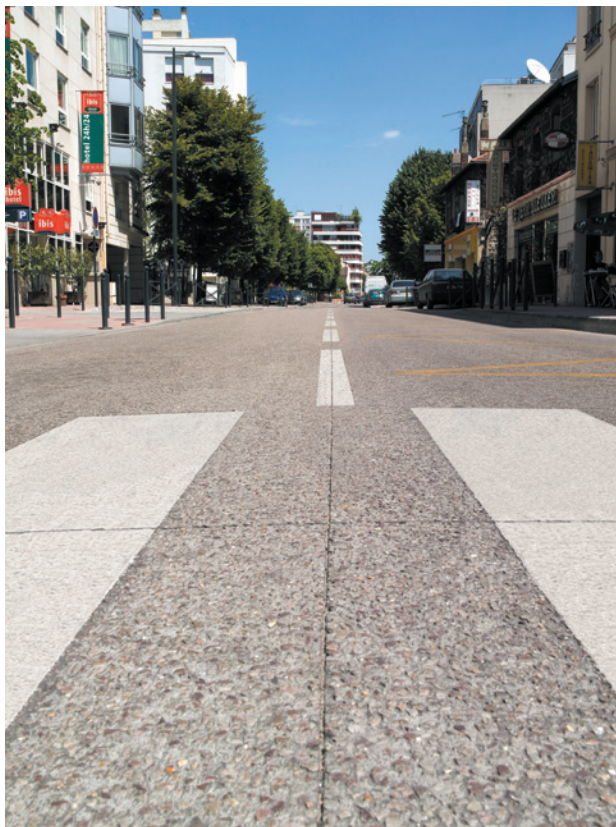
Béton à fonction dépolluante
