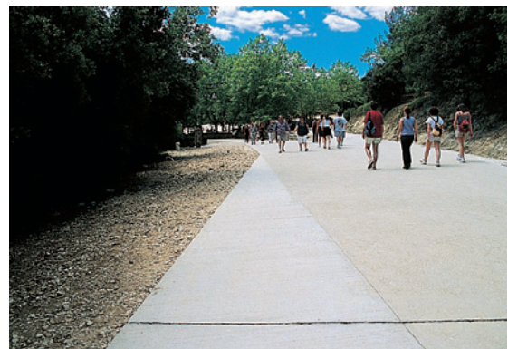
Revêtement clair à fort pouvoir réfléchissant
