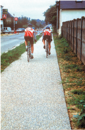
Structure réservoir en béton poreux
