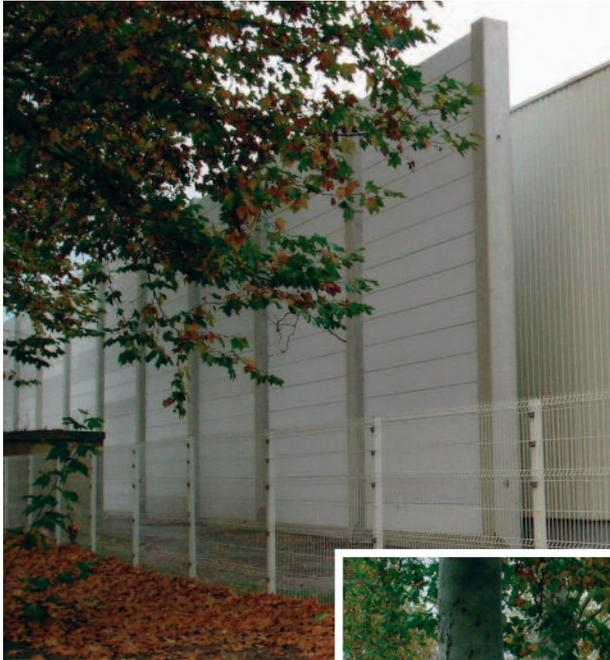
*Pour protéger les tiers d'un éventuel incendie du bâtiment, un mur coupe-feu autostable (façade à fonction d'écran thermique), a été construit entre le bâtiment et la clôture.*
