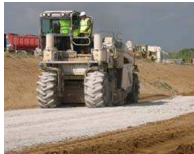
Sol avant traitement
