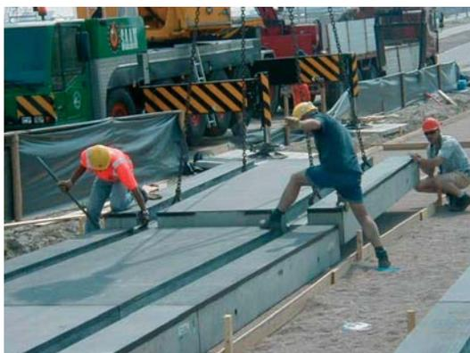
*Pose de dalles préfabriquées à Lausanne de 4 m de longueur. Les dalles sont alignées puis le jointement est effectué grâce à un mélange de mortier de ciment.*
