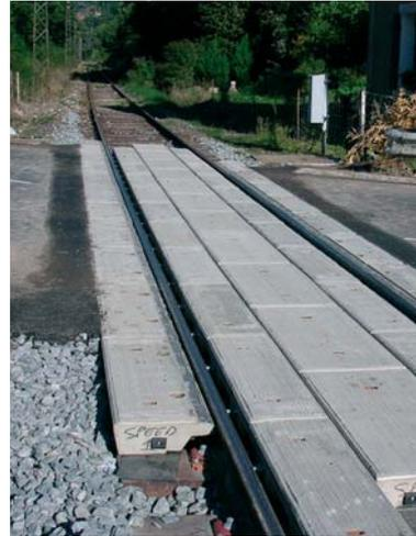
*Platelage PVF sur bibloc. Les éléments préfabriqués, utilisés dans les passages à niveau, peuvent être employés également dans les tunnels.*
