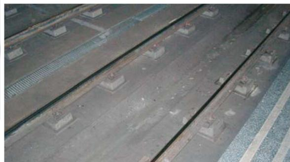
*La dalle en béton de la ligne de métro n° 8, à Madrid, présente un évidement permettant la sauvegarde des personnes tombées sur la voie et facilitant le nettoyage.*
