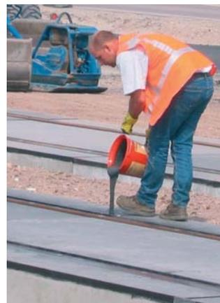
*Mise en place de la résine de fixation du rail dans la réservation de la dalle en béton.*
