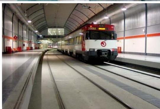
*Les rails encastrés dans la dalle en béton permettent aux engins de secours de rouler sur la voie de la gare d'Alcobendas (banlieue de Madrid).*
