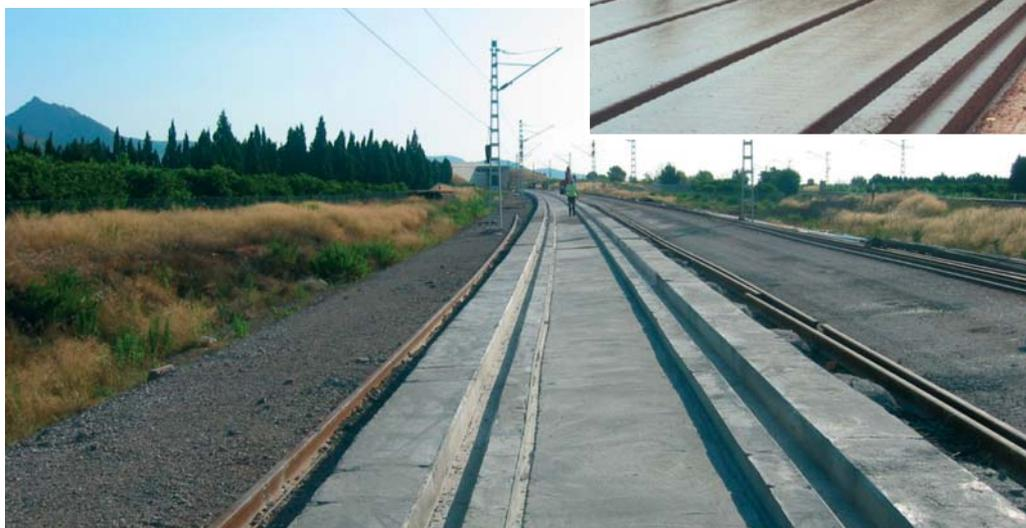
*Vue en coupe d'une dalle en béton pour une voie à grande vitesse.*
