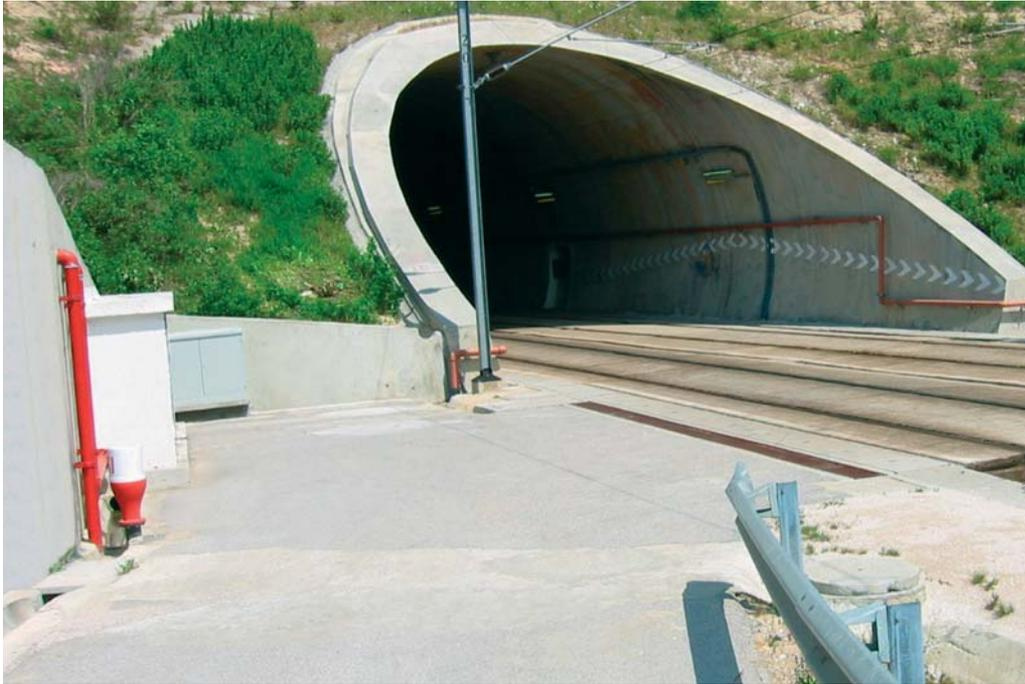
*Tunnel de Pragal (voie d'accès pompiers en béton), on distingue le poteau d'incendie pour l'alimentation de la colonne sèche.*
