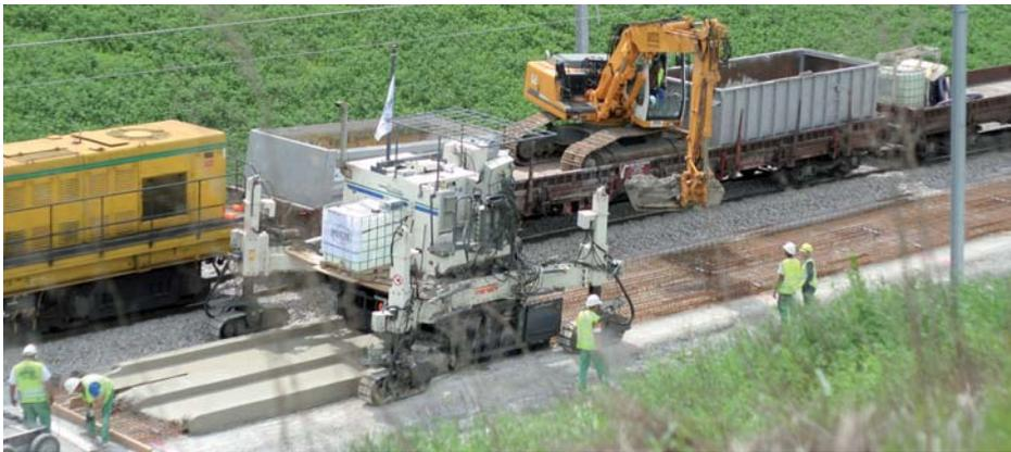
Le projet représente deux voies de 1 800 ml chacune, incluant un appareil de voie permettant le passage d'une voie sur l'autre. La section est décomposée en deux, la moitié en courbe avec des dévers accusant jusqu'à 10 %, le reste étant en alignement droit.
