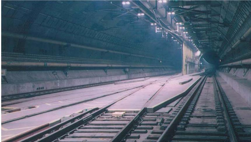
La surface de la dalle mince en béton armé est réglée avec une tolérance de l'ordre du centimètre. Les rails sont fixés sur des selles élastiques. Celles-ci sont réglées puis scellées dans le béton, permettant d'obtenir le niveau exact du plan de roulement des rails, conformément aux tolérances prescrites par la SNCF. Cette pose permet d'envisager une augmentation future de la vitesse des trains. Elle facilite son entretien par l'emploi de matériels mécanisés et informatisés.
