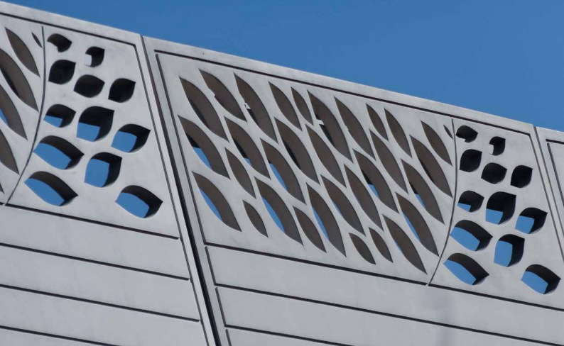
Détail Centre des congrès d'Aix-en-Provence/ Arch. Réno-Ray Mitchell Agence Arcan/ © Photo A. Reymond
