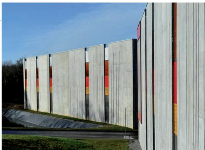
→ À Saint-Nazaire, la STEP est mixée avec un centre de formation. Les bâtiments techniques sont réalisés en béton brut ponctuellement rythmé de joints creux.
