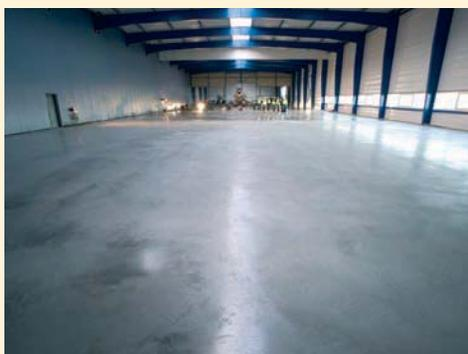
métalliques ni treillis soudé, des dalles unitaires de 20 m x 20 m ont été réalisées. La surface possède une excellente résistance à l'abrasion et la mise en charge a pu intervenir après 14 jours, à la grande satisfaction du maître d'ouvrage qui a pu reprendre sa production dans un délai raccourci et qui bénéficiera, à l'usage, de coûts de maintenance réduits.
