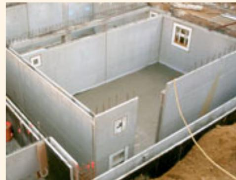
**Sous-sols en Alsace.** Deux exemples de solution "prémur" mise en œuvre en Alsace. Deux jours seulement sont nécessaires pour la mise en œuvre du sous-sol, pose et bétonnage des panneaux compris. L'aspect final est lisse, sans bullage, prêt à être peint, lasuré ou enduit. Le prémur peut aussi rester brut.
