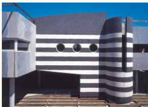
fées, placées en fond de moule avant coulage du béton noir. Les composants de base sont un ciment blanc et des granulats des Pyrénées pour les bandes blanches, et un ciment gris, un colorant et des granulats de Chalonnès pour le béton noir. Les panneaux les plus longs atteignent 6 m, et leur poids de 12 tonnes a imposé l'utilisation d'une grue de 110 tonnes de capacité pour 17 m de bras.
