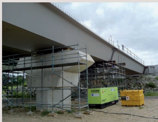
→ Ouvrage en cours de construction.
