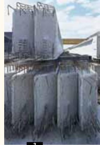
**>>> 1** Après ouverture du banc de pré-fabrication, les aciers actifs sont relâchés pour mettre la poutre en précontrainte.
