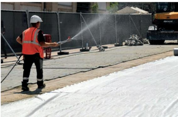
Un géotextile est déployé pour protéger la nouvelle chaussée. But : renforcer encore la prise du béton. Il sera arrosé toutes les heures jusqu'au soir.
