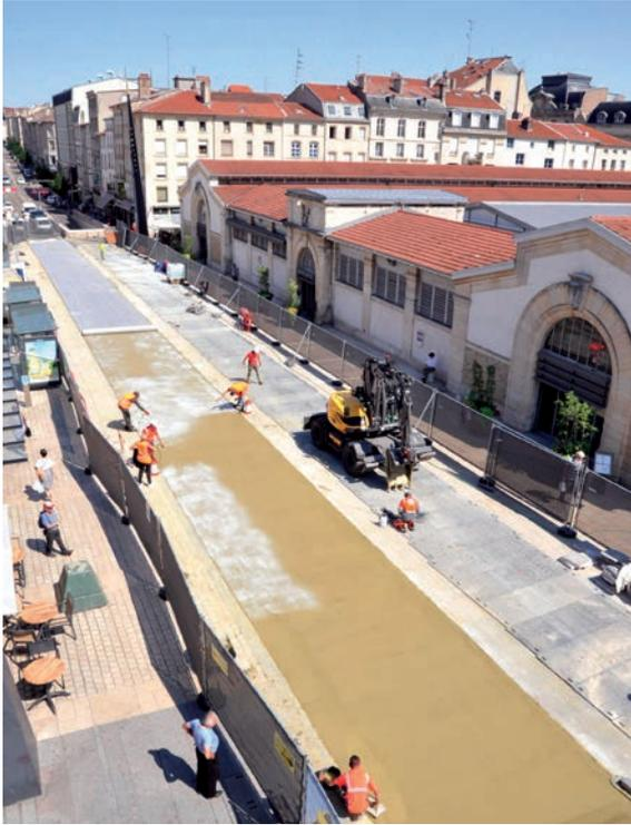
Du premier plan à l'arrière-plan, les différentes étapes du chantier : lissage, pulvérisation du produit de cure, déploiement du géotextile.
