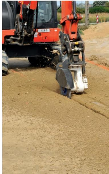
Le département de la Drôme a opté pour la technique préventive de préfissuration. Le groupement E26-Guintoli a mis en œuvre deux systèmes de sciage, dont une dent crantée montée sur une pelle, intervenant systématiquement tous les quatre mètres pour canaliser les éventuelles fissures transversales.
