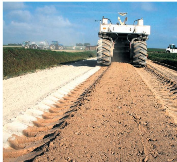
Le pulvimixeur malaxe et homogénéise le liant avec le matériau de l'ancienne chaussée.
