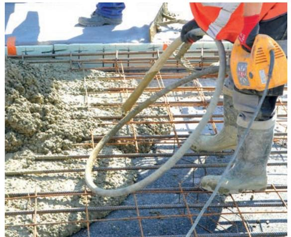
Une aiguille vibrante est utilisée pour chasser les bulles d'air et assurer une bonne compacité.
