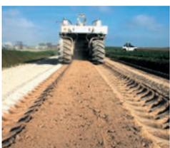
PHOTO DE COUVERTURE // Retraitement en place de 4 km sur la RD 96 entre Origny-le-Sec et Orvilliers-Saint-Julien (10). Le pulvimixeur malaxe et homogénéise le liant avec le matériau de l'ancienne chaussée.
