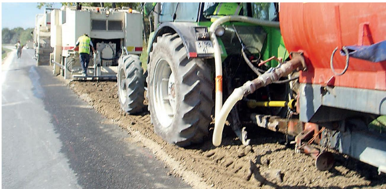
L'atelier de retraitement de chaussée réalise plusieurs opérations : fraisage, épandage et malaxage.
