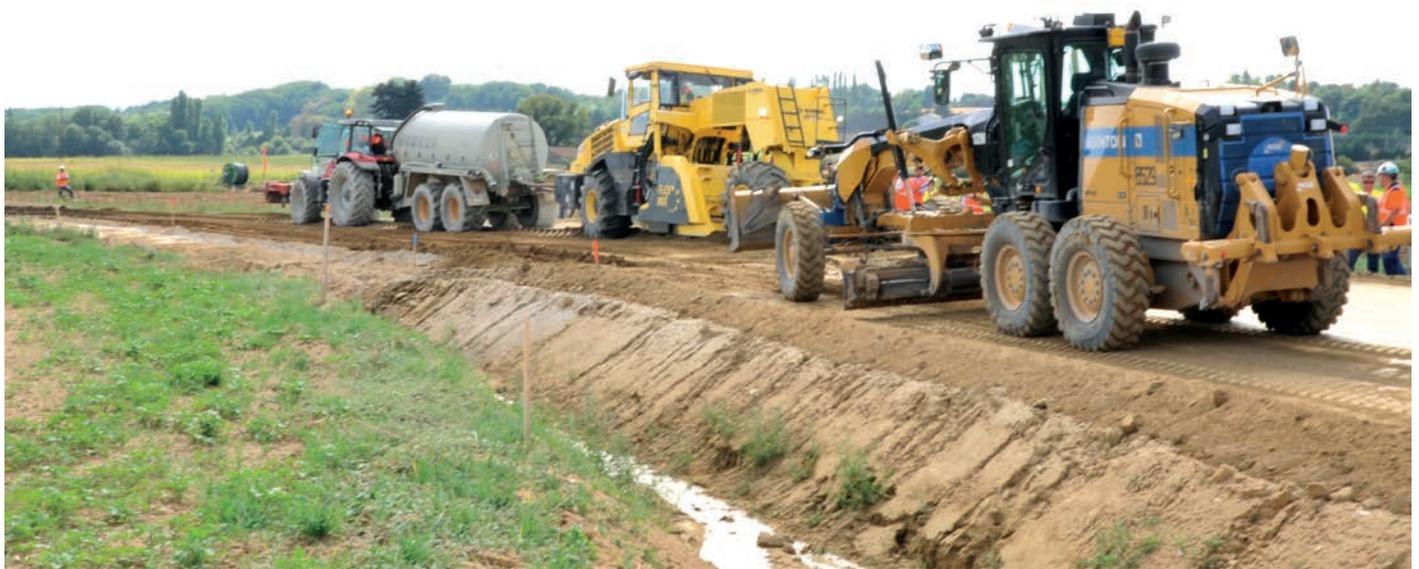
L'atelier de retraitement du groupement E26-Guintoli (groupe NGE), en cours d'intervention. Il était constitué d'un malaxeur Bomag RS 650, alimenté par une citerne d'eau. Le liant hydraulique retenu pour le retraitement était du Rolac Optimum LT, à raison de 38 kg/m<sup>2</sup> (traitement à 5 %). Humidification : 40 litres d'eau au mètre carré.
