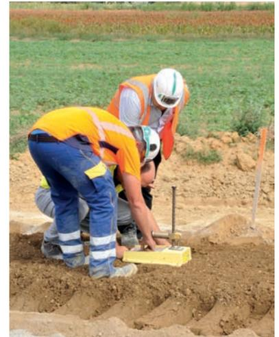
Derrière le malaxeur Bomag RS 650, un technicien vérifie visuellement l'homogénéité du mélange entre le matériau de l'ancienne chaussée et le liant hydraulique, et un autre mesure la teneur en eau du matériau traité.
