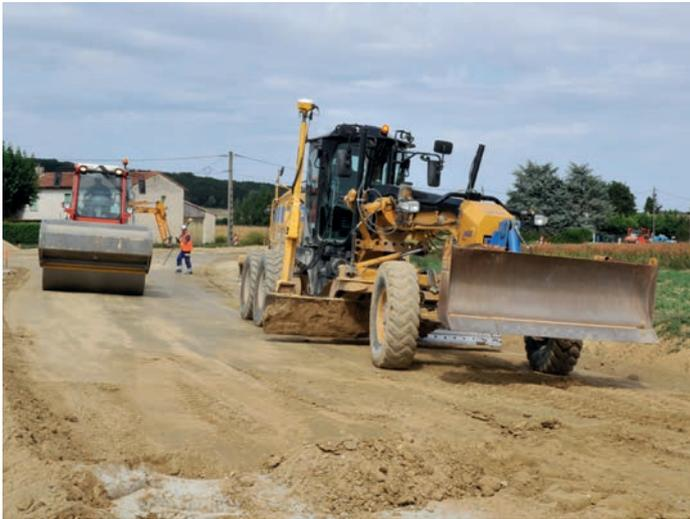
Derrière le malaxeur, la mise en œuvre se poursuit avec le nivellement de la chaussée (à droite) et le compactage du matériau (à gauche).
