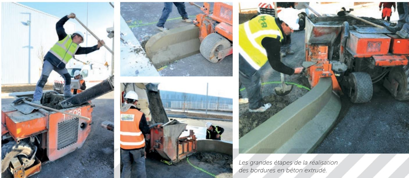
Les grandes étapes de la réalisation des bordures en béton extrudé.
