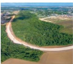
PHOTO DE COUVERTURE // Vue aérienne de la déviation d'Étampes (Essonne), dernier tronçon du programme de désenclavement du parc Sud Essor. Le chantier a nécessité un traitement de sol, préalablement renforcé de fibres de chanvre, au liant hydraulique routier (LHR).
