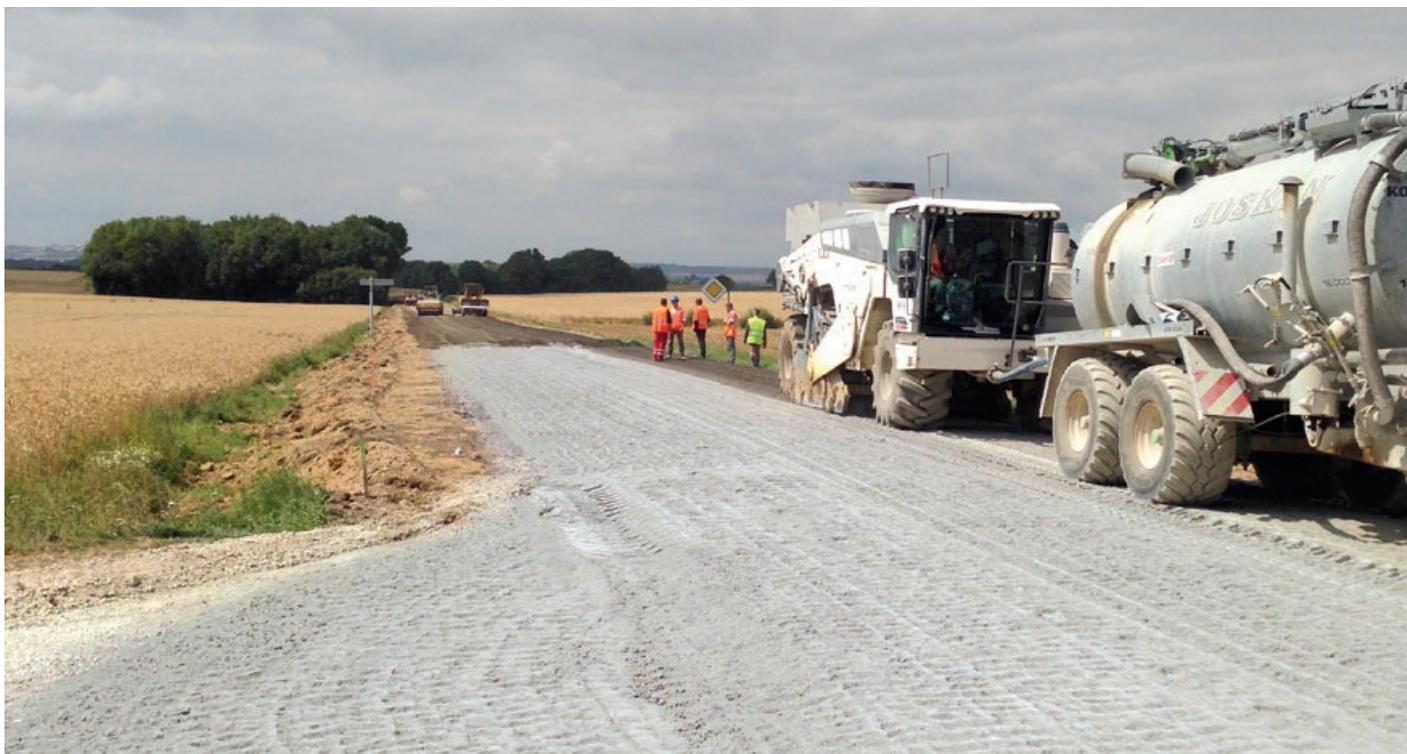
Vue générale du chantier avec, au premier plan, la machine de malaxage alimentée en eau par une citerne, et en arrière plan, la niveleuse et l'atelier de compactage.
