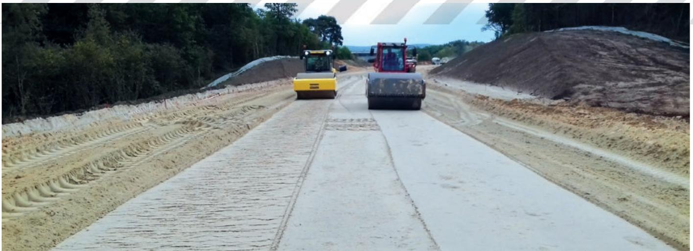
Atelier de compactage de la couche de forme traitée au chanvre et au liant hydraulique routier.
