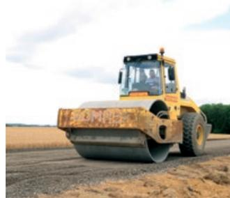
L'atelier de compactage composé d'un « vibrant » (un cylindre monorouveau V5) et d'un « pneu » (un PS 300).
