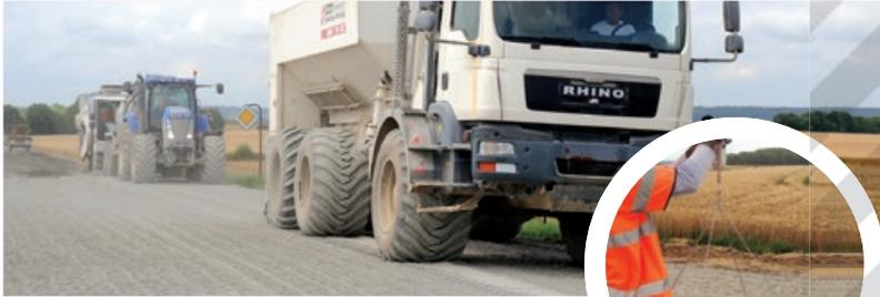
Épandage du liant hydraulique routier LVTS 54 de Vicat et vérification de la bonne répartition du liant au mètre carré (méthode dite « à la bêche »).
