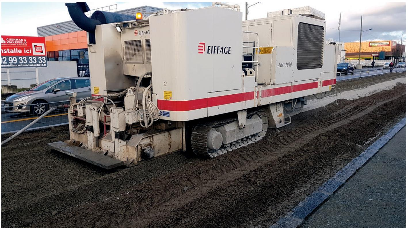
L'ARC 1000® mélange les matériaux en place (matériaux blancs et bitumineux) et le liant hydraulique routier. L'homogénéité transversale et verticale du résultat est optimale (valeur 3 pour le paramètre H du coefficient HEPIL).
