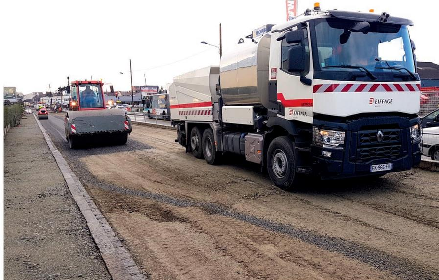
Au premier plan, un PATA (point à temps automatique, épandeur de liant et gravillonneur sur le même châssis) suivi d'un atelier de compactage.
