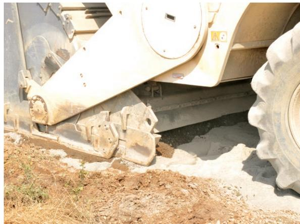
Une Wirtgen 2400 intervient pour mélanger le matériau de l'ancienne chaussée avec le liant sur une épaisseur de 35 cm.
