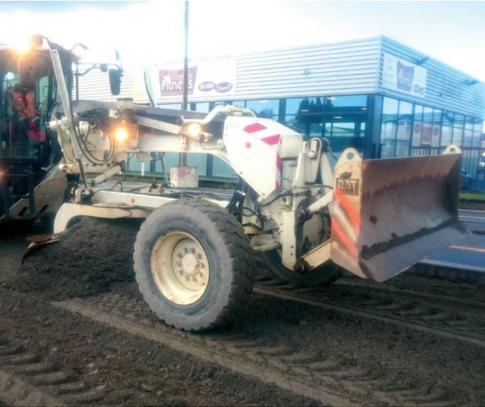
Le matériau obtenu est réglé selon le profil déterminé à l'aide d'une niveleuse guidée par GPS.
