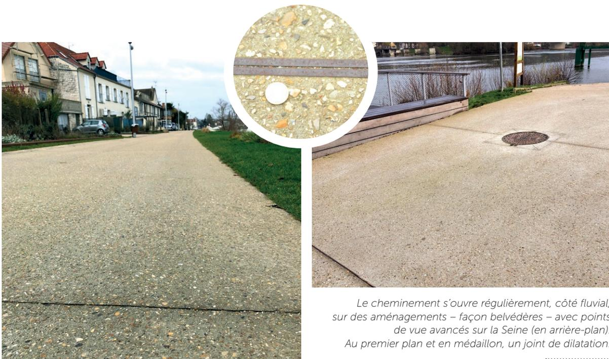
Le cheminement s'ouvre régulièrement, côté fluvial, sur des aménagements – façon belvédères – avec points de vue avancés sur la Seine (en arrière-plan). Au premier plan et en médaillon, un joint de dilatation.
