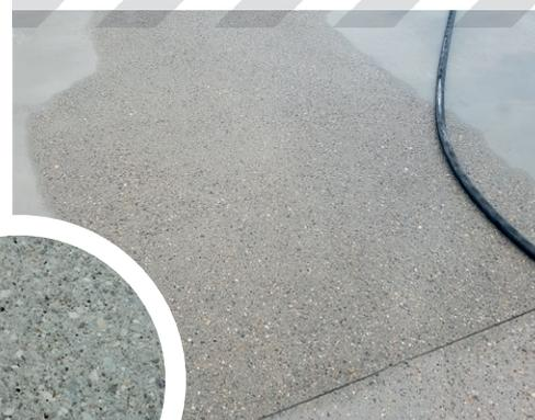
Quarante-huit heures après la mise en œuvre, un atelier d'hydrosablage par voie humide est intervenu pour retirer la peau du béton et faire apparaître les granulats.
