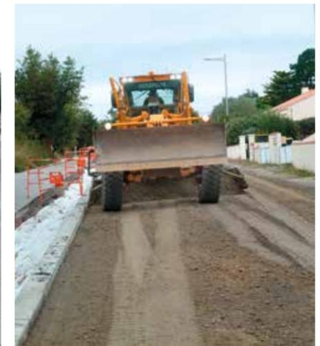
▲ Après épandage du liant, le malaxeur mélange intimement le liant et les matériaux de l'ancienne chaussée. ▲ Réglage du matériau retraité à la niveleuse.
