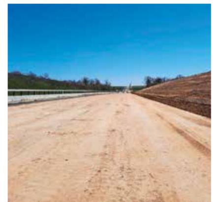
La liaison entre Toulon-Sur-Allier (Allier) et Digoïn (Saône-et-Loire) fait appel massivement à la technique de traitement des sols en place au liant hydraulique routier LHR.
