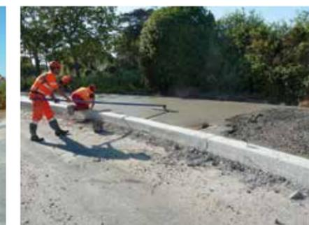
Talochage de la surface du béton.
