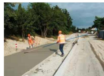
Balayage transversal du béton.
