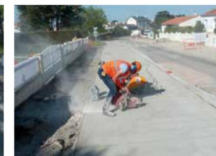
Exécution des joints de retrait par sciage.
