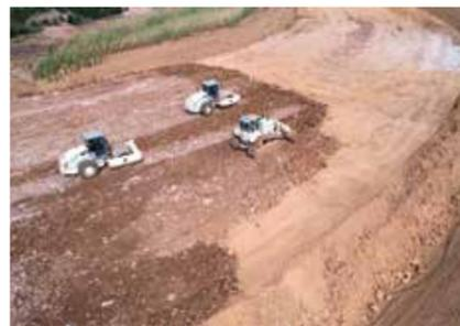
▲ Vu d'ensemble des travaux de réalisation du remblai, par couches successives.
