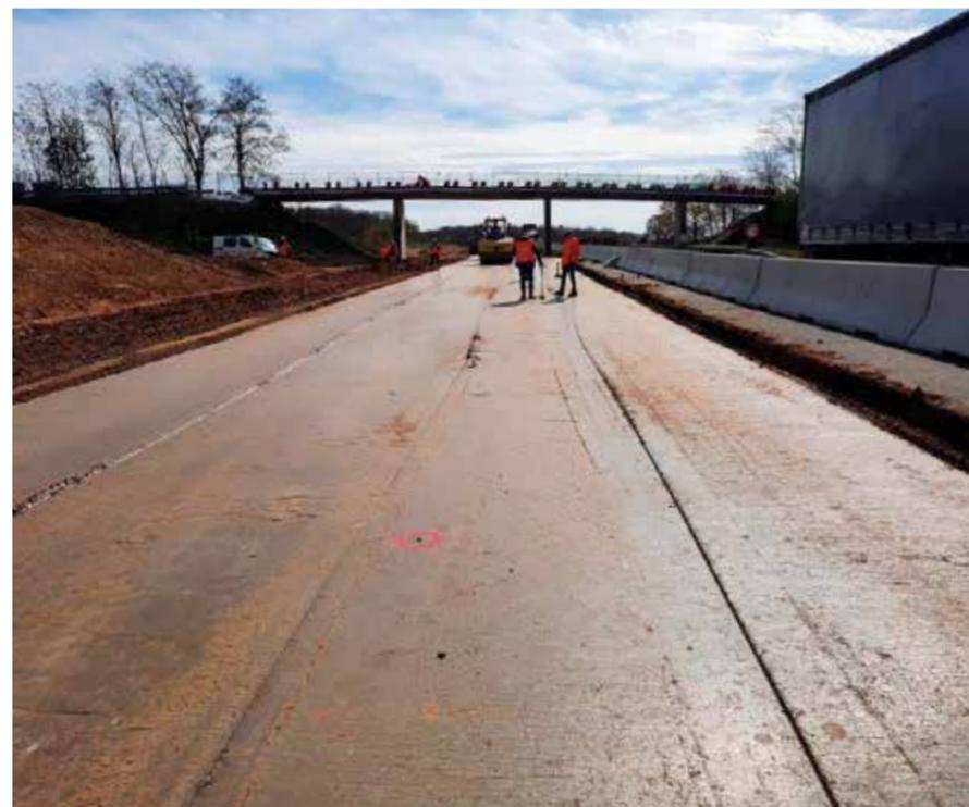
➔ Contrôle du compactage au gamma-densimètre.
