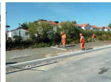
Vibration superficielle du béton.
