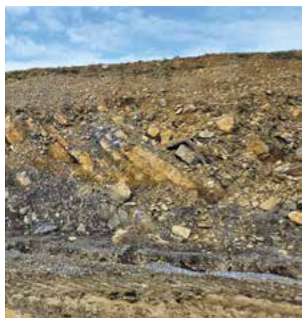
↑ Ci-dessus. Affleurements de roches schisteuses mis à jour au cours des terrassements en déblais. ©Guillaume Tisserand/Lafarge France
