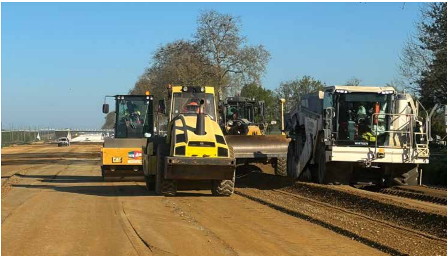
↑ Vue d'un atelier de traitement des matériaux en place au liant LV-TS 03. (©Joseph Abdo/ JA-Consulting)
