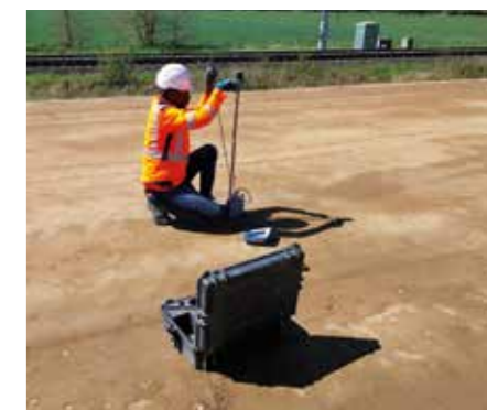
↑ Contrôle de compactage au pénétromètre dynamique léger à énergie variable Panda. (©Joseph Abdo/JA-Consulting)
