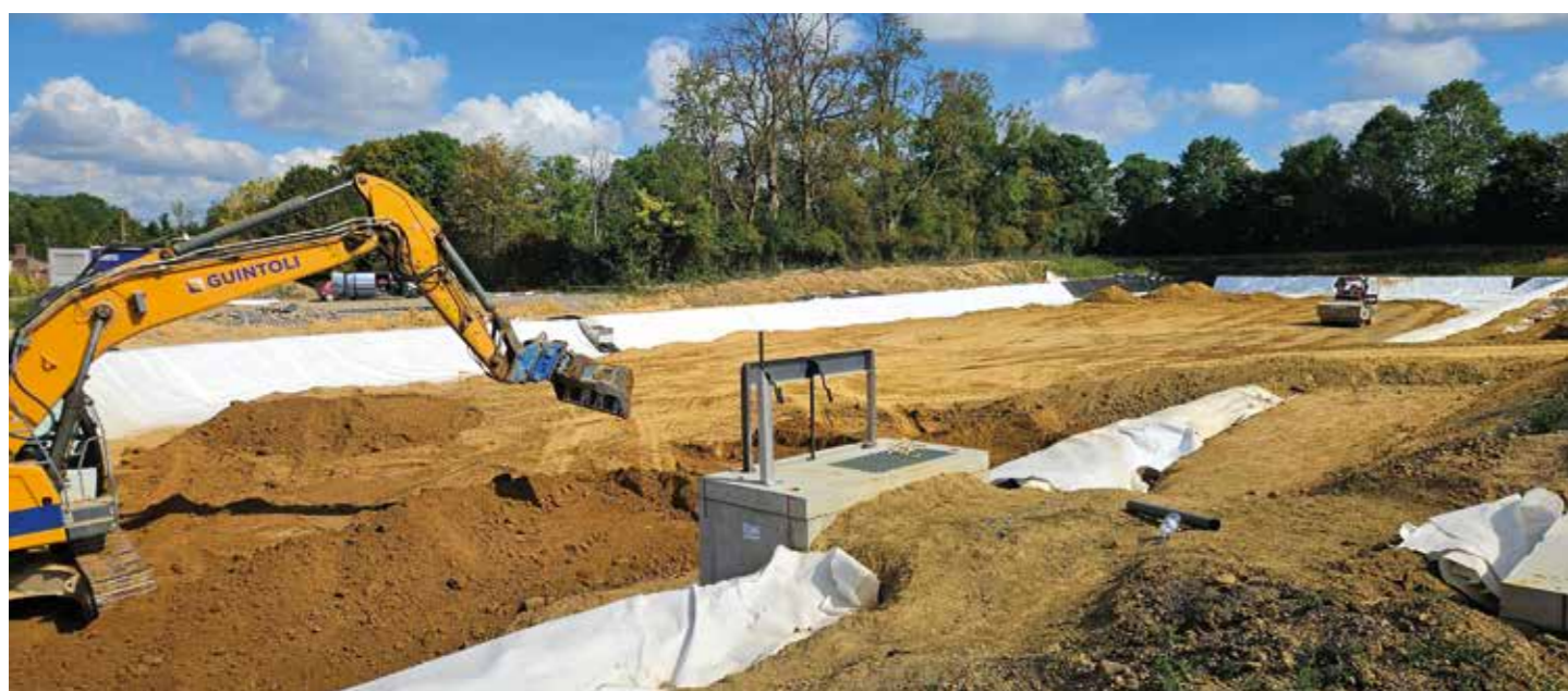
Ci-dessus. ↑ Réalisation d'un bassin de décantation par traitement du sol en place au LHR Dorosol C. ©Guillaume Tisserand/Lafarge France
