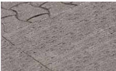
Le balayage de surface du béton améliore l'adhérence des véhicules sur le sol.
