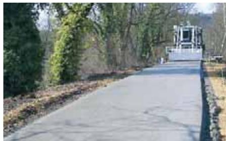
La piste en béton a été coulée sur 14 centimètres d'épaisseur en moyenne, sur un fond de forme de calcaires du site.
