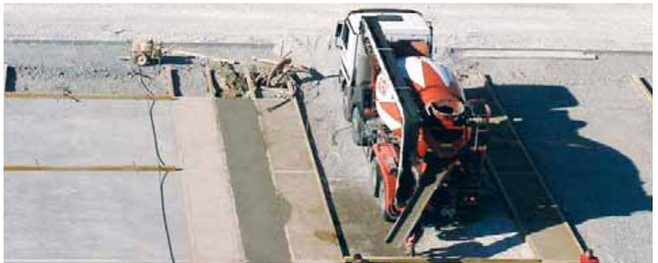
Une partie du calepinage en bois a été déposée pour permettre aux toupies de béton prêt à l'emploi d'accéder jusqu'aux dalles à couler en place.
