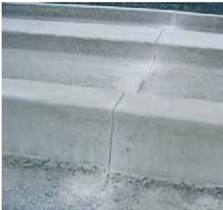
Les joints de fissuration, de 5 à 10 mm d'épaisseur, ont été sciés tous les 5 mètres après le coulage de la dalle. Le profil endenté de la dalle permet de positionner les traverses.
