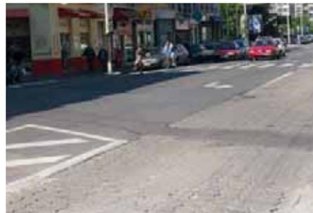
Orniérage et déformation des arrêts de trolleybus en pavés autobloquants.
