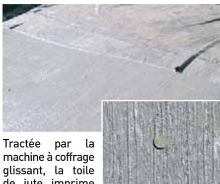
Tractée par la machine à coffrage glissant, la toile de jute imprime son motif au béton, au fur et à mesure de l'avancement.
