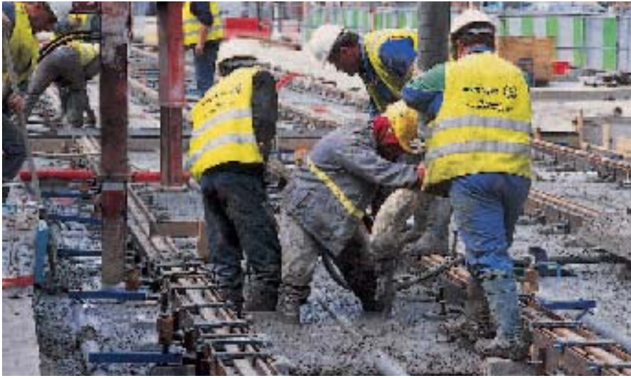
Blocage des traverses en béton par coulage.
