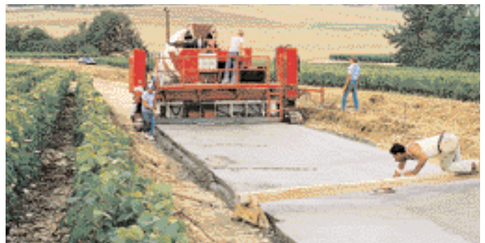
Mise en œuvre à la machine à coffrage glissant.
