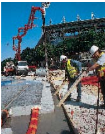
Immobilisation des éléments de carrefour par injection de béton liquide.
