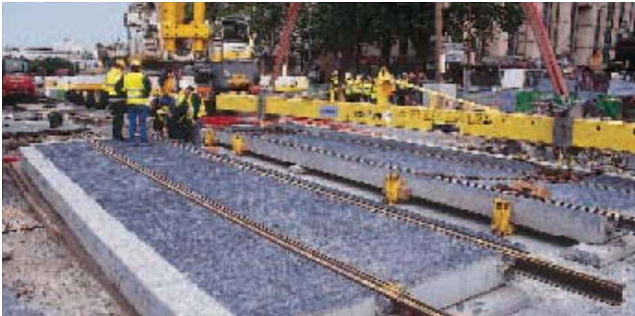
Mise en place, sur un carrefour, d'une dalle préfabriquée en béton.
