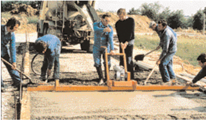
Mise en œuvre à la règle vibrante.
