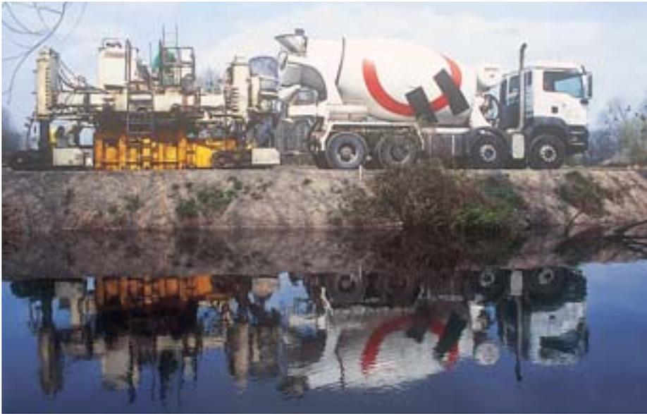
L'atelier mobile de mise en œuvre, avec camion-toupie et machine à coffrage glissant.
