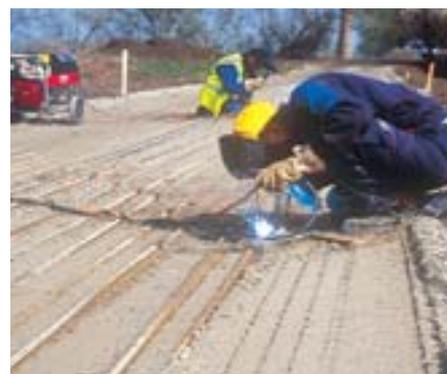
Les fers à béton de 16 mm de diamètre sont soudés bout à bout pour assurer la continuité de l'armature.
