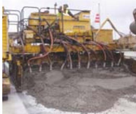
Le béton est guidé, en avant de la machine, par des fils tendus de chaque côté de la dalle à couler.
