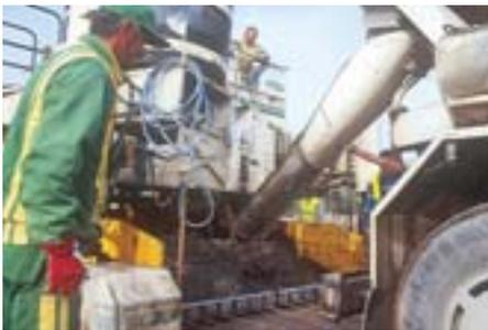
Le peigne, disposé à l'avant de la machine à coffrage glissant, assure le bon positionnement des fers longitudinaux.
