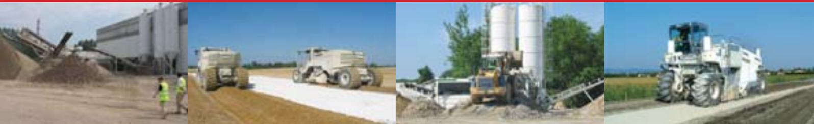
**C077** Le retraitement en place au ciment-émulsion de la RN19 à Nador
