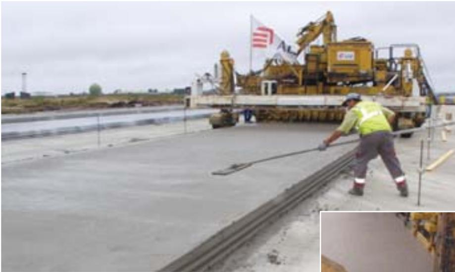
Après sa mise en place, le béton est vibré par la machine, puis la dalle est talochée. On aperçoit que les flancs de la bande de roulement, coulés sur la dalle de béton maigre, sont dotés d'un profil sinusoïdal qui assurera le transfert de charge avec la dalle suivante.
