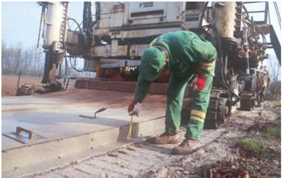
Vérification de l'épaisseur du B.A.C., au fur et à mesure de l'avancement du chantier.
