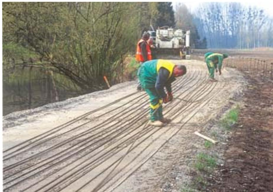
Les fers à béton longitudinaux sont disposés avant le passage de la machine à coffrage glissant.
