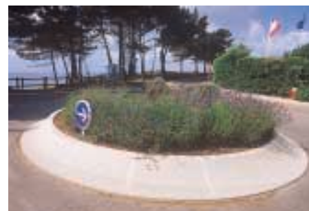
Giratoire de la Pointe St Gilles en béton préfabriqué clair.
