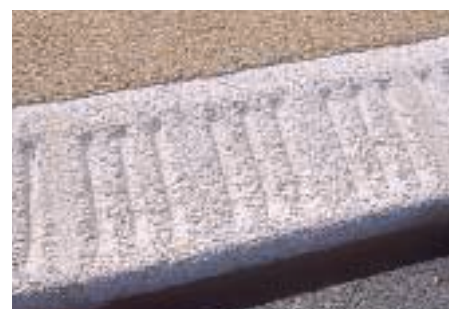
Bordure d'îlot directionnel en ciment blanc et granulats naturellement rétro-réfléchissants (quartz, mica).
