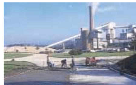
La variabilité des largeurs de chaussée a imposé une mise en œuvre manuelle.
