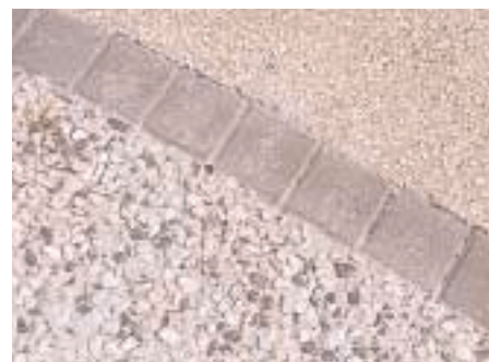
Promenade de Port-Neuf : site dévasté par la tempête de 1999 et réaménagé à l'aide de deux bétons désactivés et de pavés béton.
