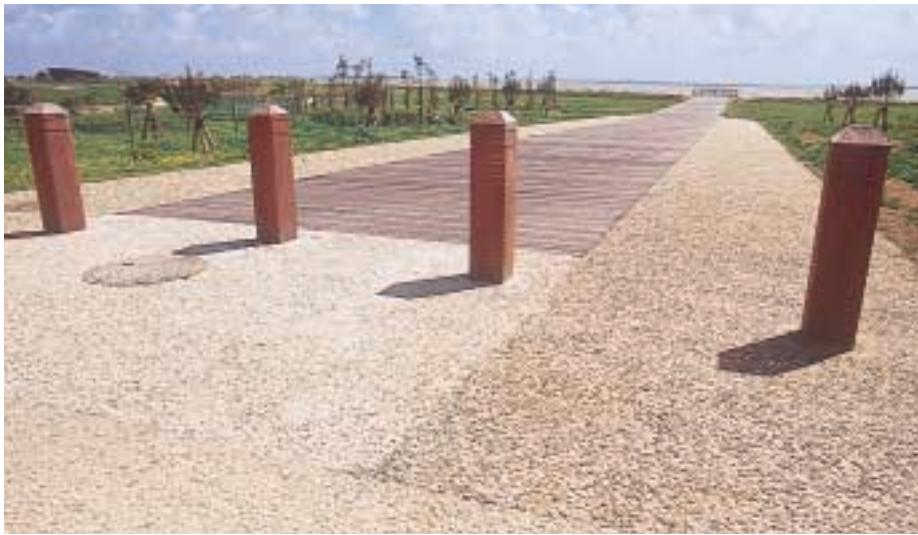
Besselue : promenade le long du littoral, pour les piétons et les cyclistes, avec granulat concassé très clair.
