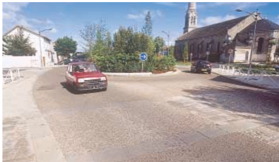
Carrefour Guiton-Missy : giratoire en béton désactivé avec passages piétons.
