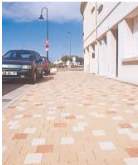
Rue de Montréal : jeu de couleurs de l'aménagement en pavés béton.
